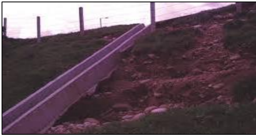
Figura 6.3 Ejemplo negativo de torrentera socavada por las aguas de escorrentía.
