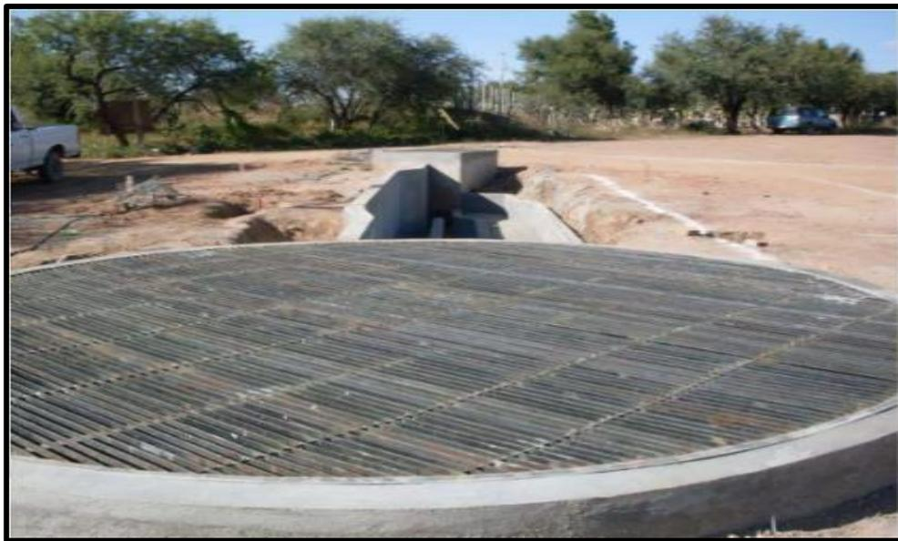
**Figura 6.8: Modelo del cárcamo de bombeo para la planta de tratamiento propuesta. (Fuente: Castañeda, 2015)**
