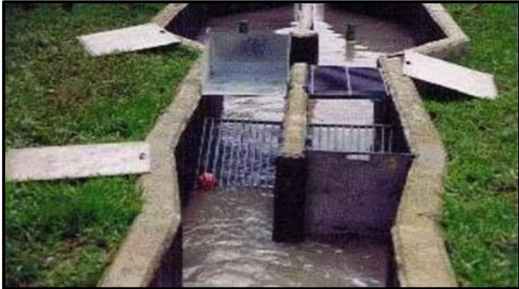
**Figura 6.6: Modelo del desarenador para la planta de tratamiento propuesta. (Fuente: Castañeda, 2015)**
