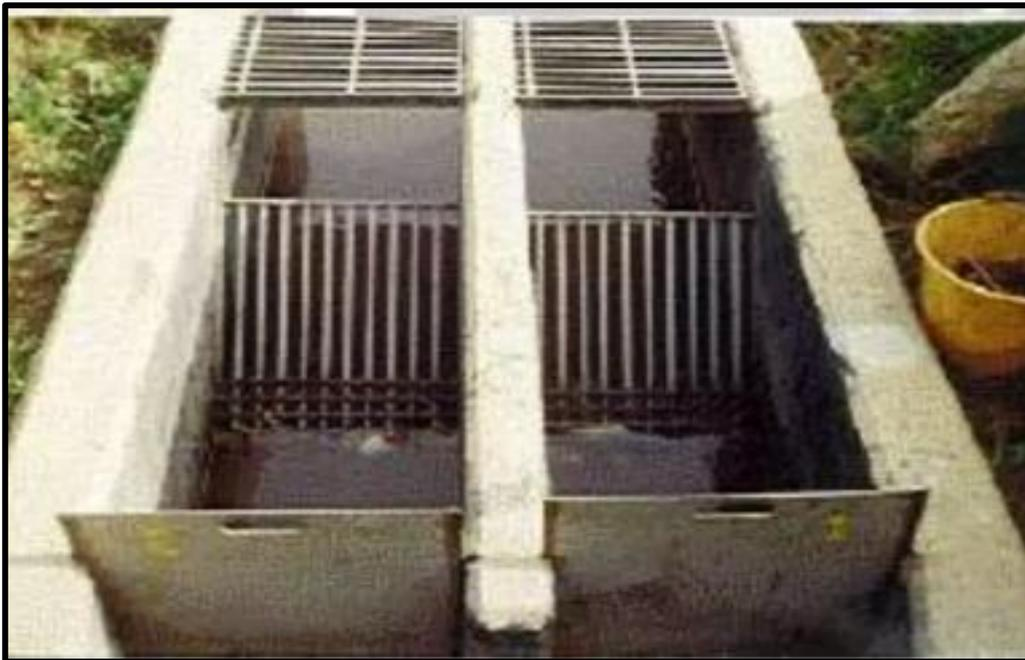
**Figura 6.7: Modelo del desarenador para la planta de tratamiento propuesta. (Fuente: Castañeda, 2015)**
