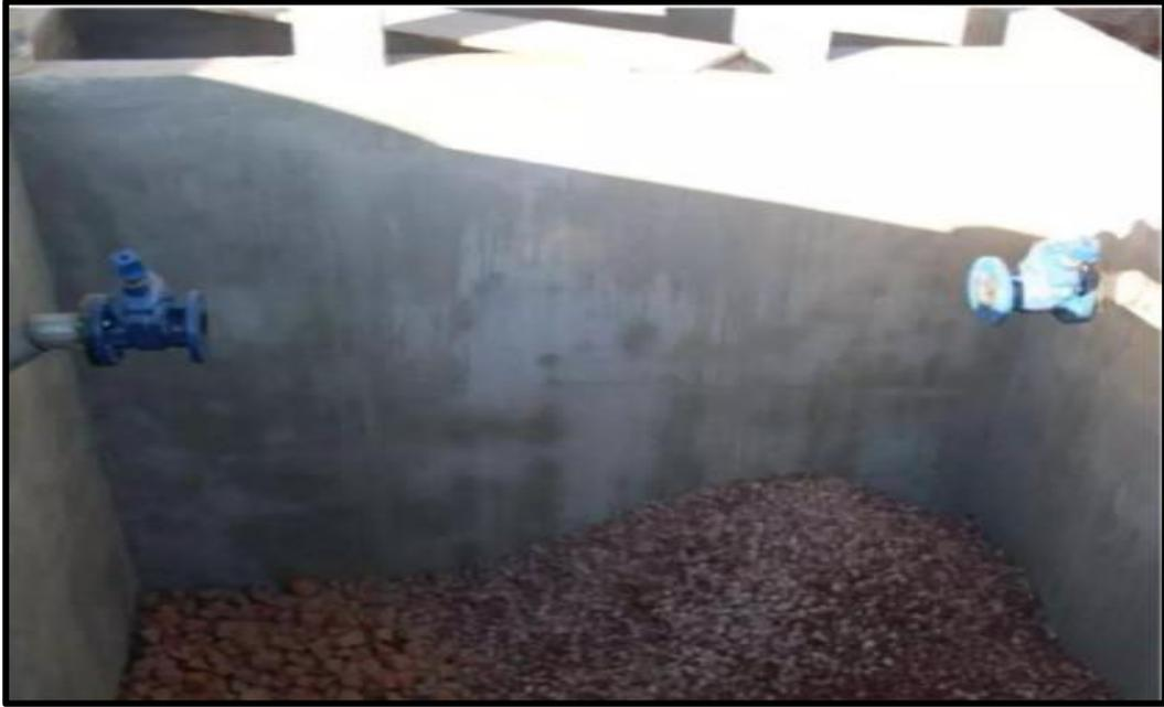
**Figura 6.10: Modelo de Tanque de secado de lodos y tanque de lixiviados para la planta de tratamiento propuesta. (Fuente: Castañeda, 2015)**
