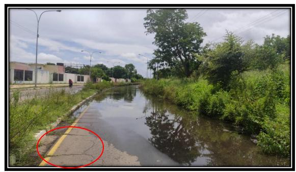
Figura 5.3 Av. Paseo Orinoco tramo estudiado, asfalto agrietado (Salazar y Vivas, 2021)
