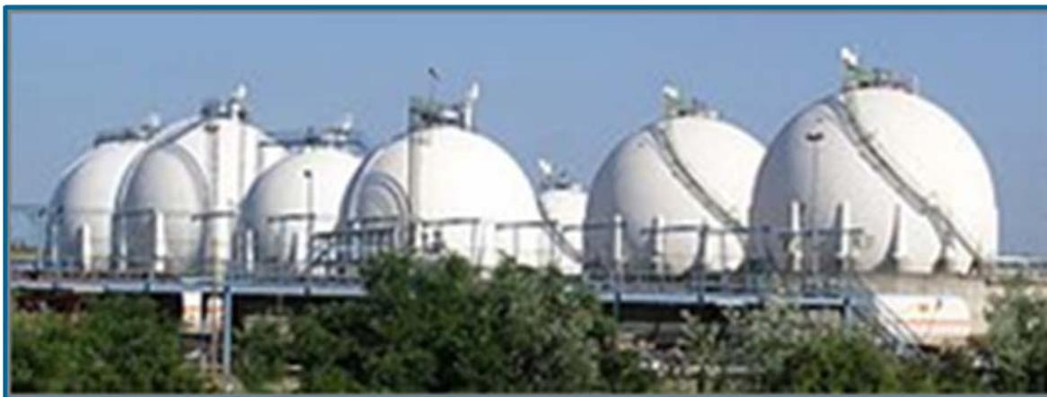
**Figura 2.5 Tanques presurizados esféricos**
