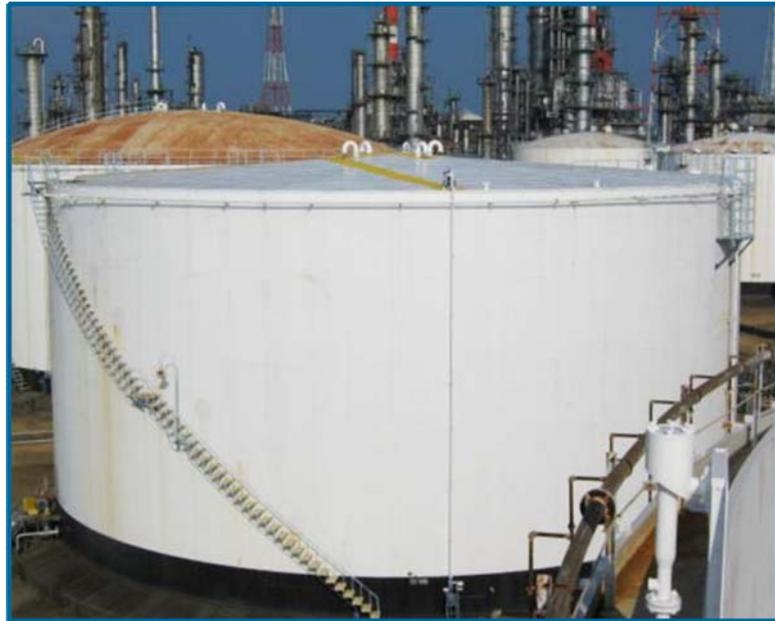
**Figura 2.1 Tanque de techo cónico**
