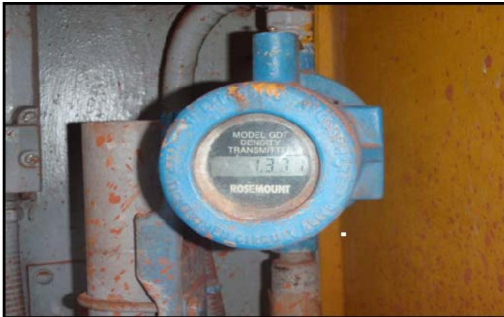
*Figura A.2 Densímetro del último lavador en operación*
