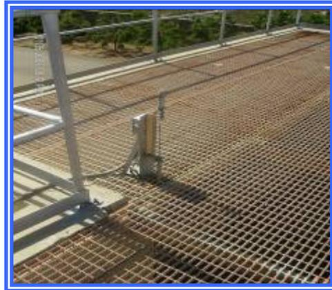
**Figura 3.1 Regleta graduada para la medición del caudal ubicada al final del tratamiento preliminar**
