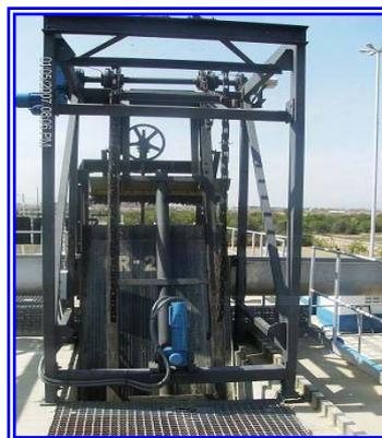
**Figura 2.1 Cribas gruesas para el pretratamiento de las aguas residuales de planta de Maurica**
