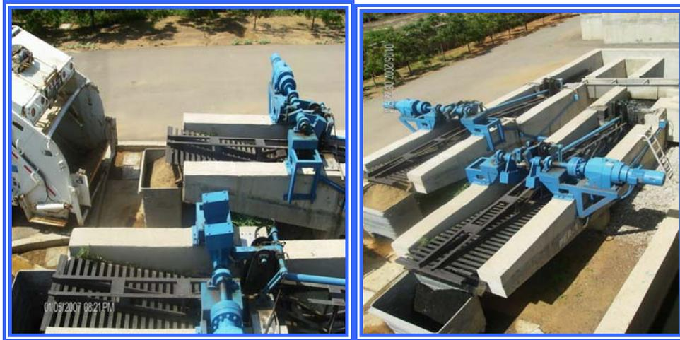
**Figura 2.3 Rastrillos desarenadores de la planta de tratamiento de aguas residuales de Maurica**
