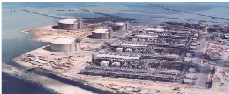
**Figura 2.10.- Tanques de contención secundaria.**
