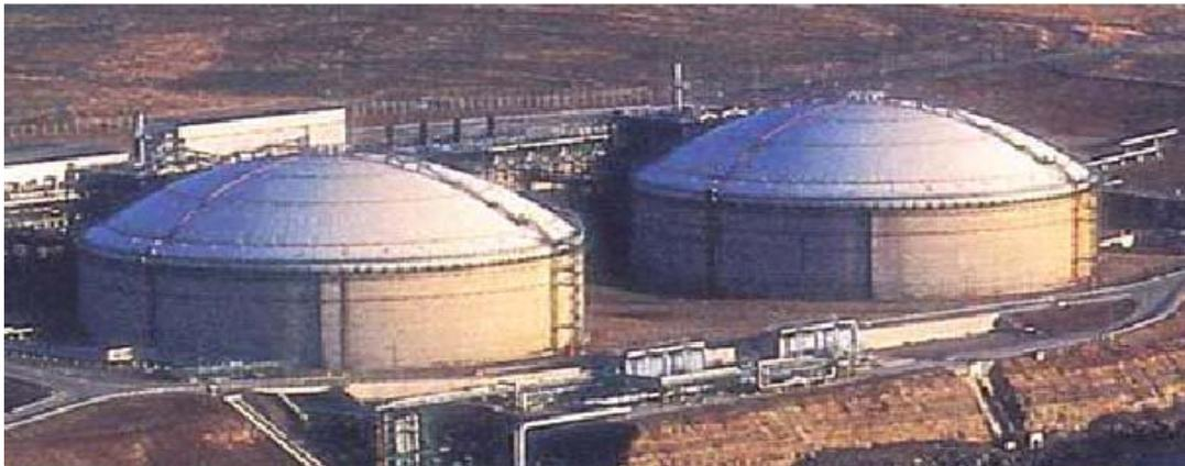
*Figura 2.11.- Tanques de contención completa.*
