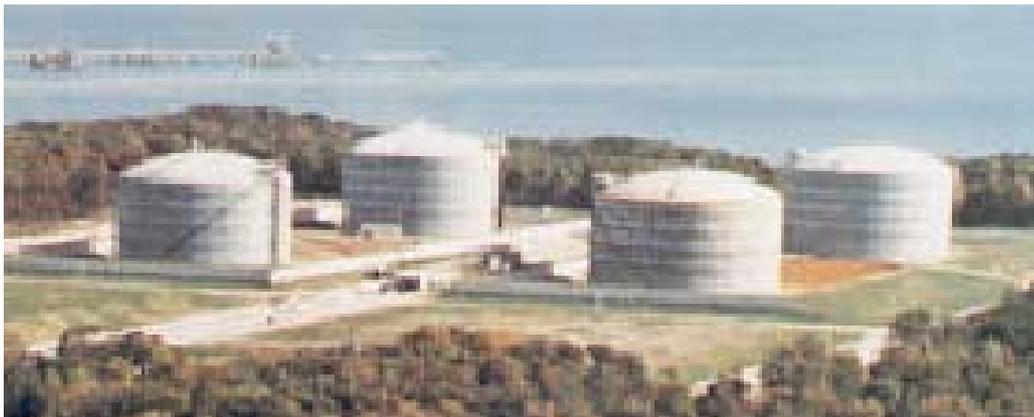
**Figura 2.9.- Tanques de contención sencilla.**
