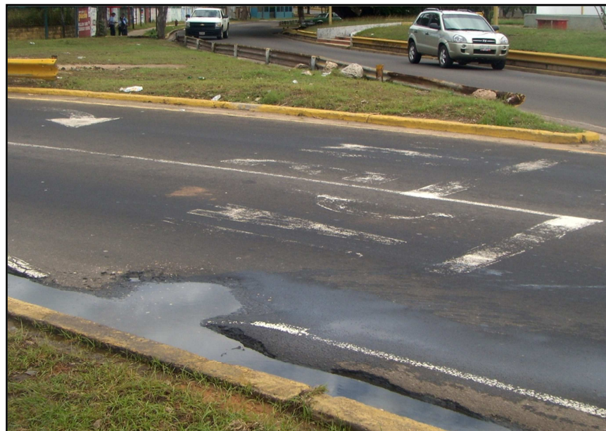
21. Condiciones de la vía. Sentido H
