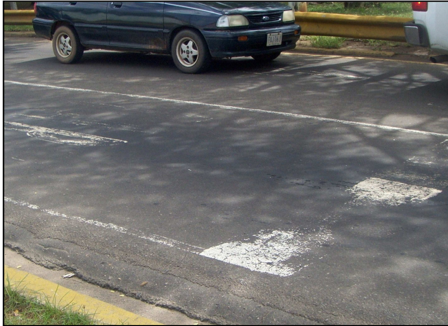
22. Condiciones de la vía. Sentido F
