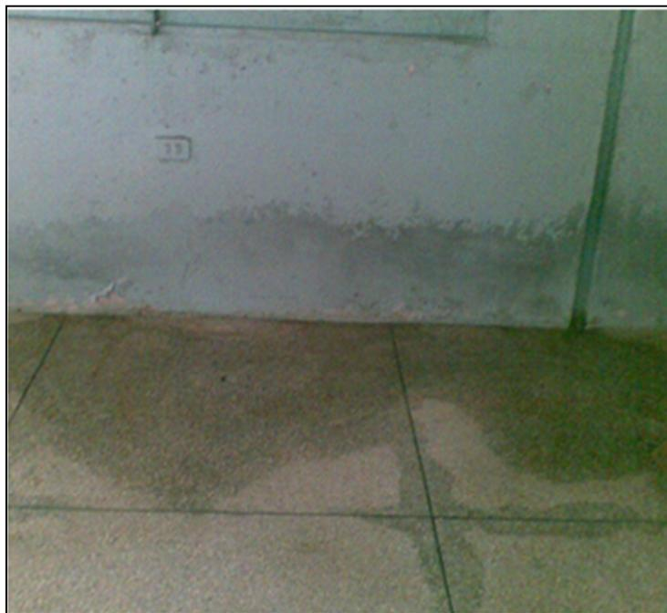
Figura 5.17 Filtraciones de aguas de lluvia a través de las paredes. (Septiembre, 2009).
