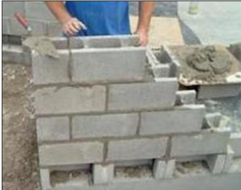
Figura 3.22 Bloque montado, presionado contra el cordón del bloque de abajo y el cordón del bloque contiguo ([www.construir.com](http://www.construir.com)).
