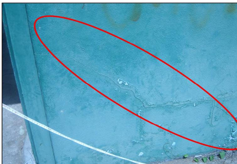
Figura 5.11 Grieta inclinada a 45° aproximadamente en la parte inferior de la pared (Julio, 2009).
