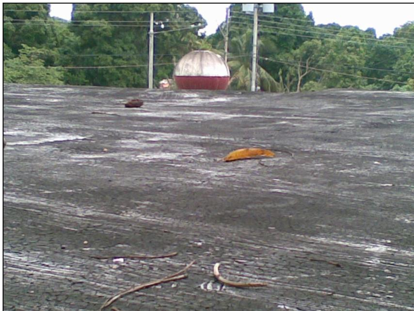
Figura 5.4 Deterioro en el manto asfáltico (Septiembre, 2009).
