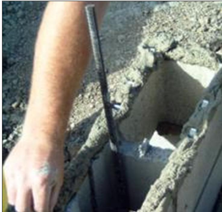
Figura 3.20 Inicio de una pared de bloque sobre una capa de mortero ([www.construir.com](http://www.construir.com)).
