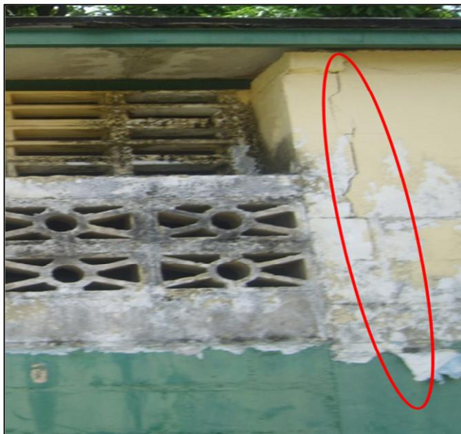
Figura 5.8 Grieta vertical en la unión de dos paredes (Julio, 2009).
