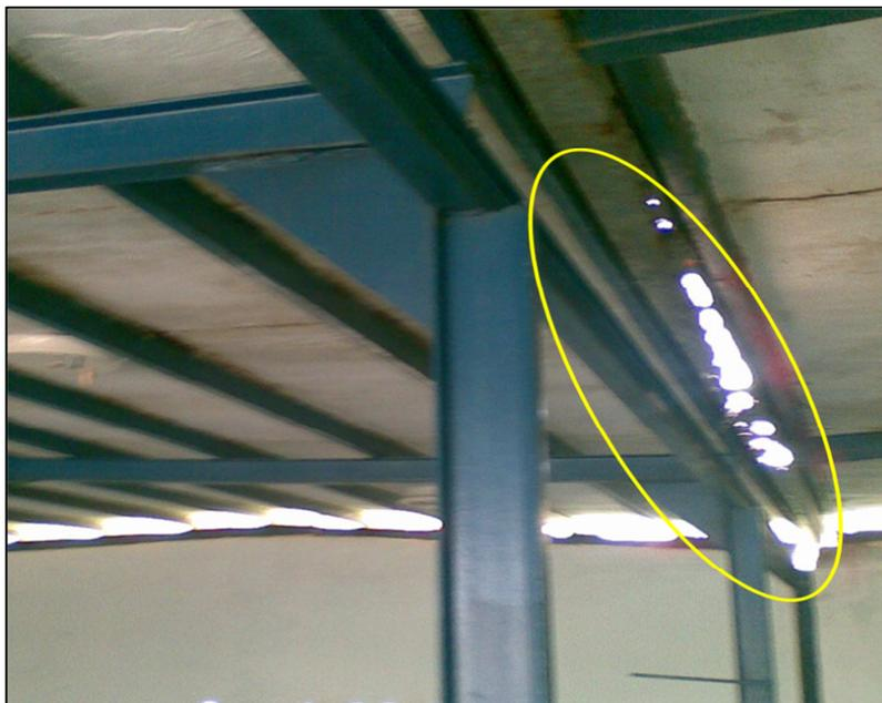
Figura 5.18 Mal estado en el que se encuentran los canales destinados a escurrir el agua de lluvia.
