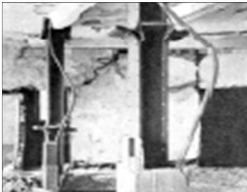
Figura 3.8 Caso extremo de deformación en estructuras porticadas (Enciclopedia Broto).
