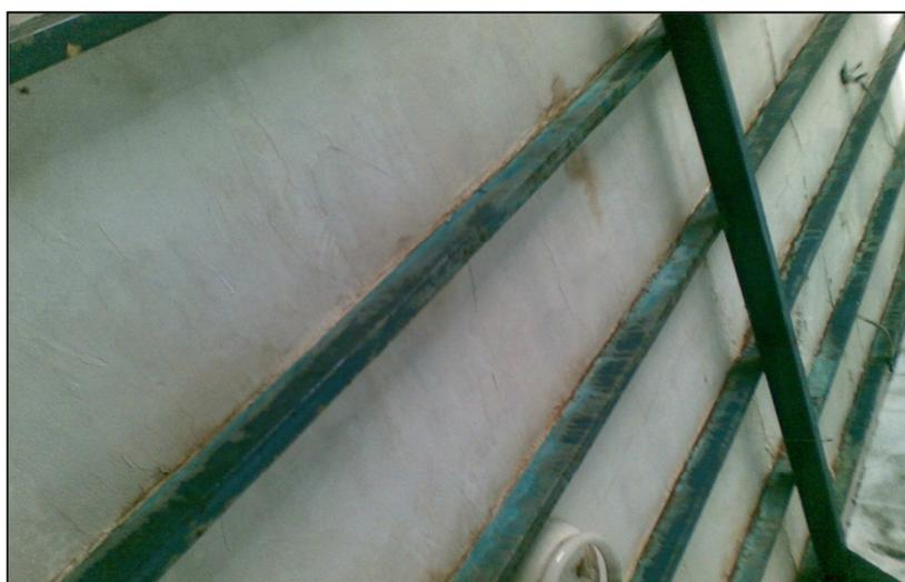
Figura 5.15 Estado oxidado y corroído en el que se encuentra la estructura. (Septiembre, 2009).
