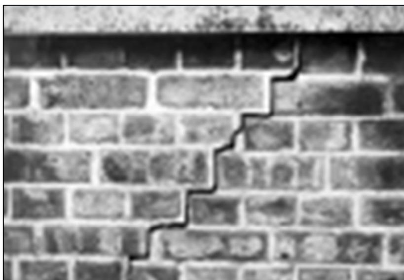
Figura 3.10 Grieta por asentamiento diferencial de un muro.
