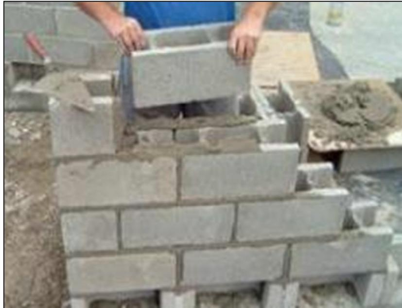
Figura 3.21 Utilización del medio bloque para alternar las filas
