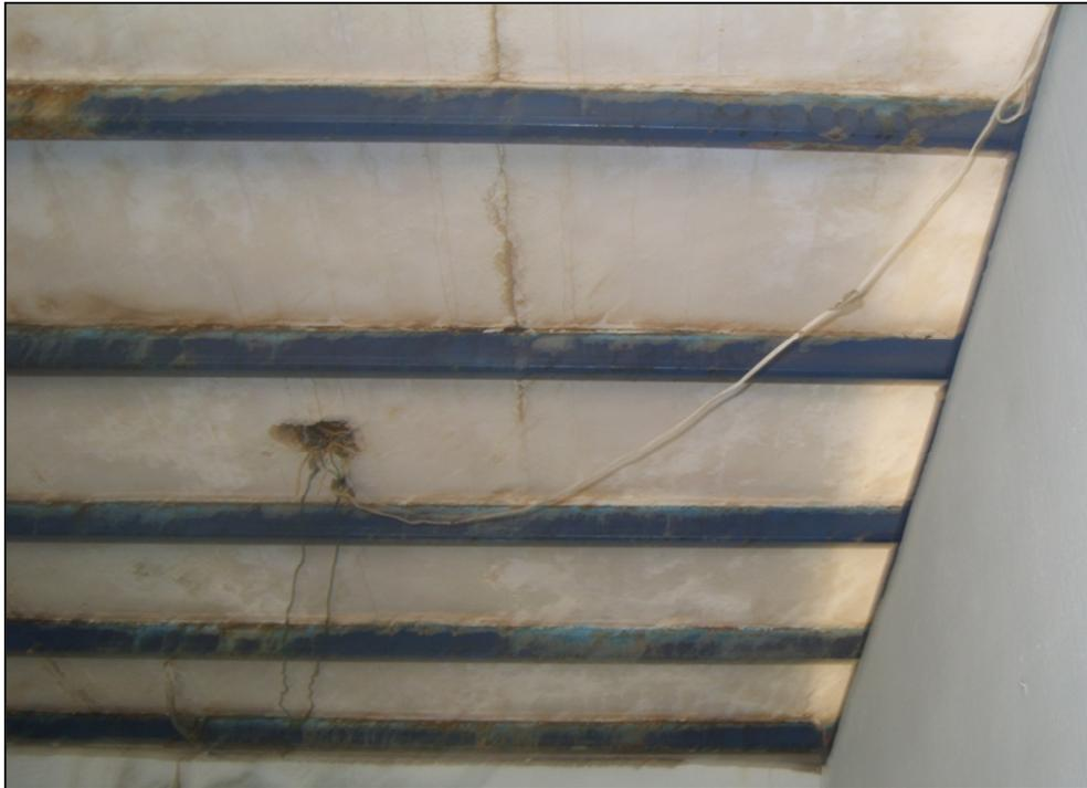
Figura 5.5 Elementos metálicos afectados por la corrosión (Julio, 2009).
