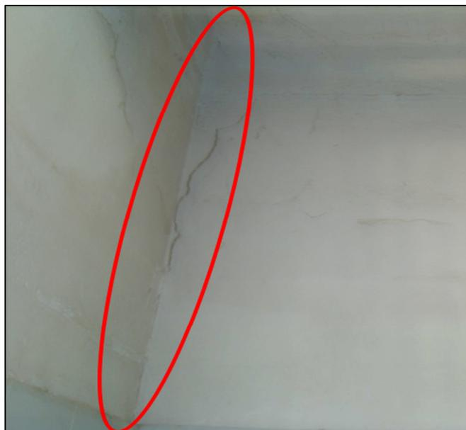
Figura 5.9 Grieta vertical en el cruce de dos paredes (Julio, 2009).
