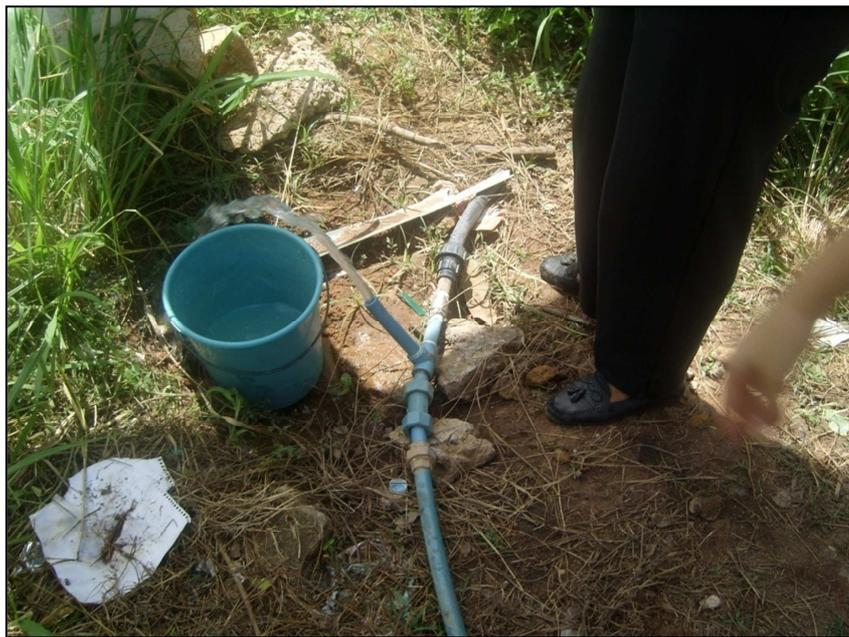
Figura 5.12 Deterioro de la tubería de aguas blancas (Septiembre, 2009).
