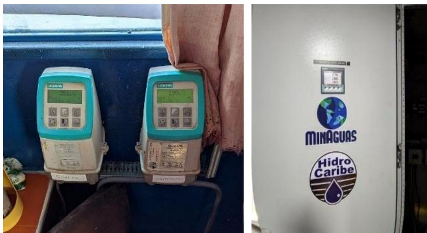
Figura 0.8 Lectores electrónicos de caudal. Fuente: Autores
