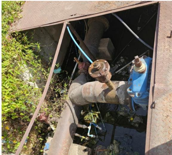
Figura 0.2 Tubería de descarga del tanque Las Charas
