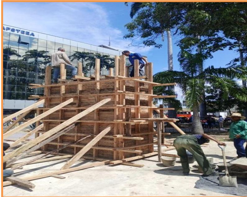
**Figura 3.21. Encofrado y vaciado de los monolitos.
