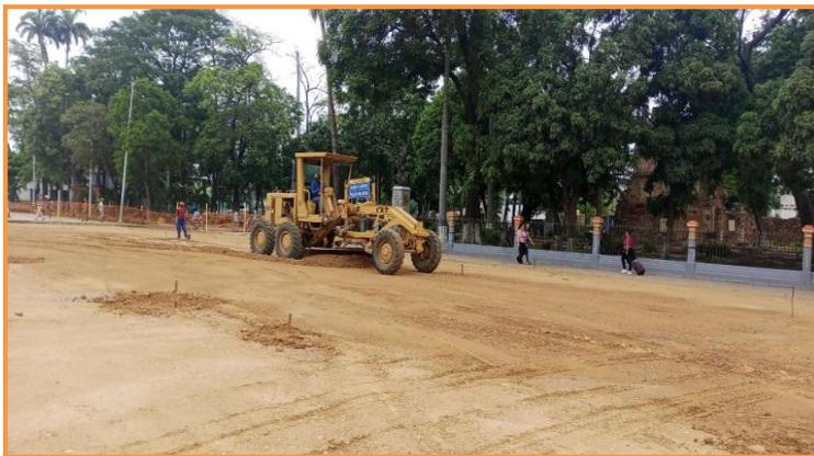
**Figura 3.12. Proceso de nivelación del suelo con maquinaria motoniveladora. Fuente: Autor (2023).**
