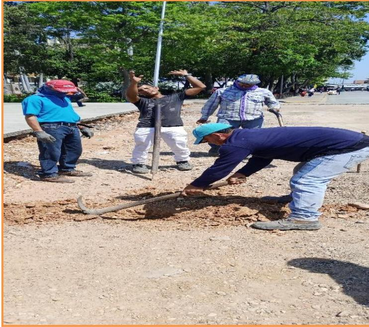
**Figura 3.7. Ejecución de la técnica de calicata, para la toma de muestra y descripción de suelo. Fuente: Autor (2023).**
