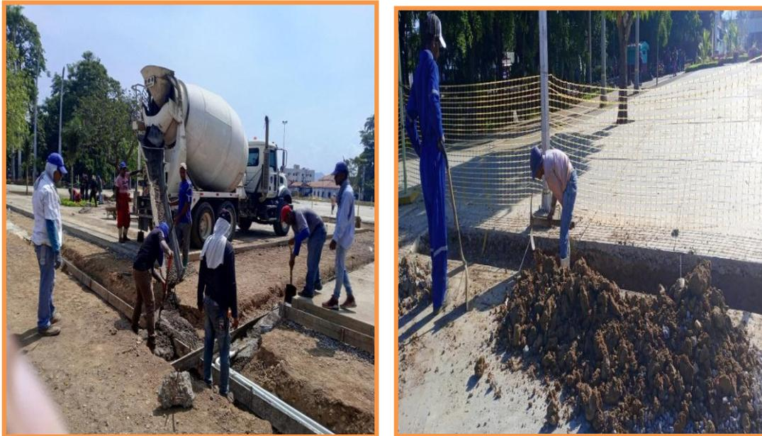
**Figura 3.18. Construcción de bancadas eléctricas y de drenajes tipo V en la obra.**
