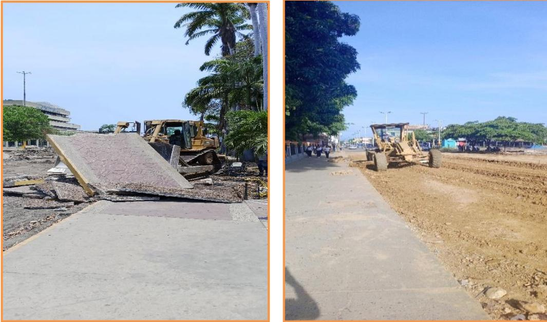
**Figura 3.1. Remoción de material de concreto de las antiguas plazas.**
