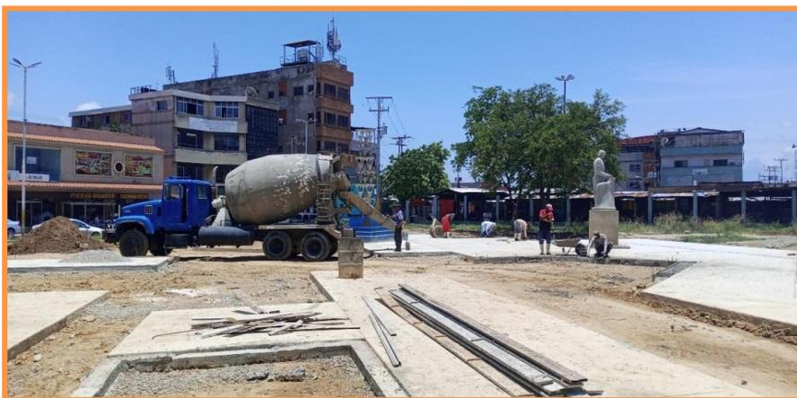
**Figura 3.15. Proceso de construcción de losas. Fuente: Autor (2023).**
