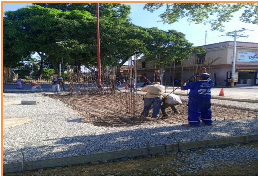
**Figura 3.20. Armado de acero para la losa de fundación y para los monolitos. Fuente: Autor (2023).**
