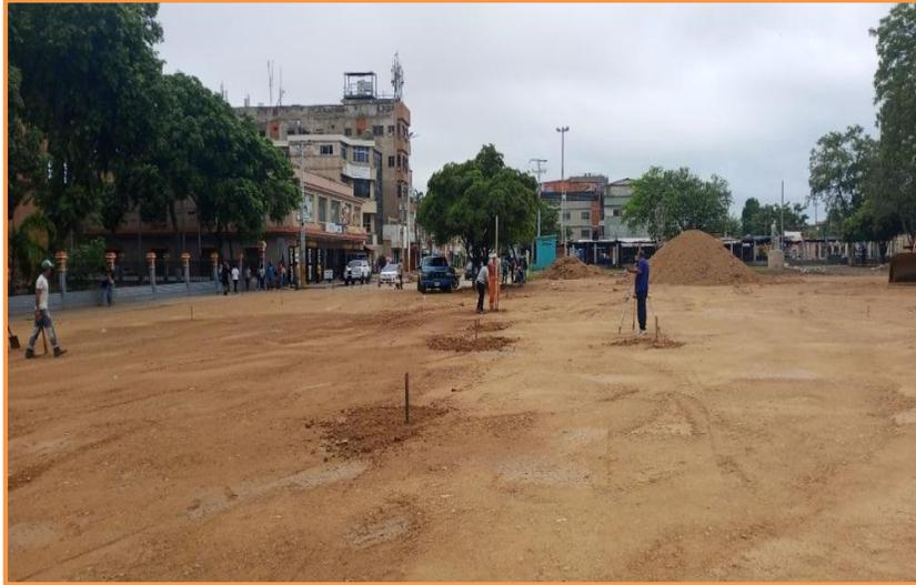
**Figura 3.6. Replanteo topográfico para definir cotas de base de piedra picada, losas de concreto y altura final. Fuente: Autor (2023).**
