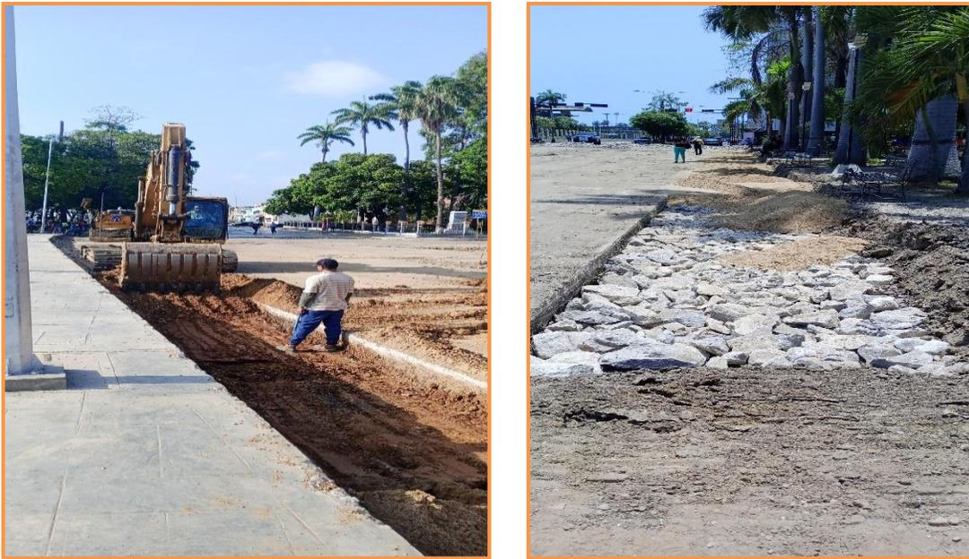
**Figura 3.8. Realización de zanjas para la construcción de los filtros subterráneos no planificados, con piedra bruta N4 del piso de concreto demolido. Fuente: Autor (2023).**
