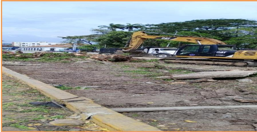
**Figura 3.4. Demolición de caminerías y brocales de las antiguas plazas.**
