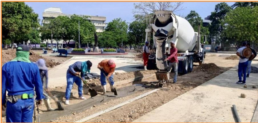
**Figura 3.10. Instalación del sistema eléctrico por bancada en la obra.
