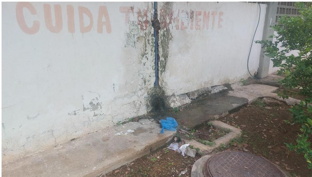
Figura 4.11. Humedad y agrietamiento en la pared.
