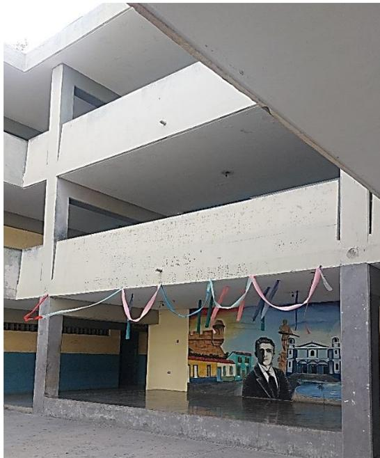
*vigas de sección transversal 40x70 cm. Ausencia de vigas en sentido transversal (dirección Y).*
