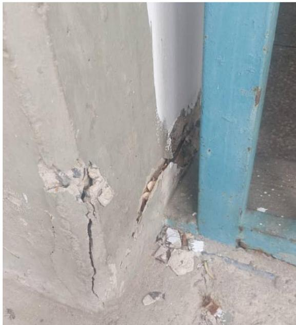
*Desprendimiento de recubrimiento en columnas*
