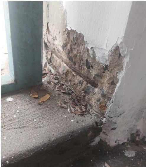
Figura 4.2. Exposición y corrosión en acero de refuerzo en la columna D8
