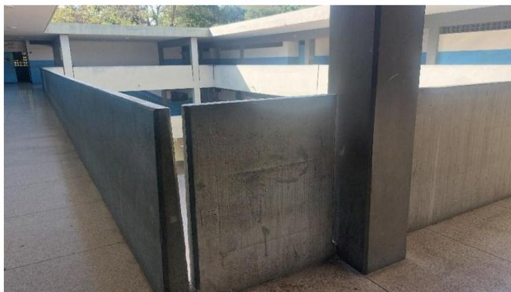
Figura 4.8. muros de concreto (antepechos)
