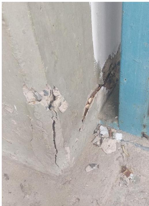
Figura 4.3. Agrietamiento del concreto en la columna E8
