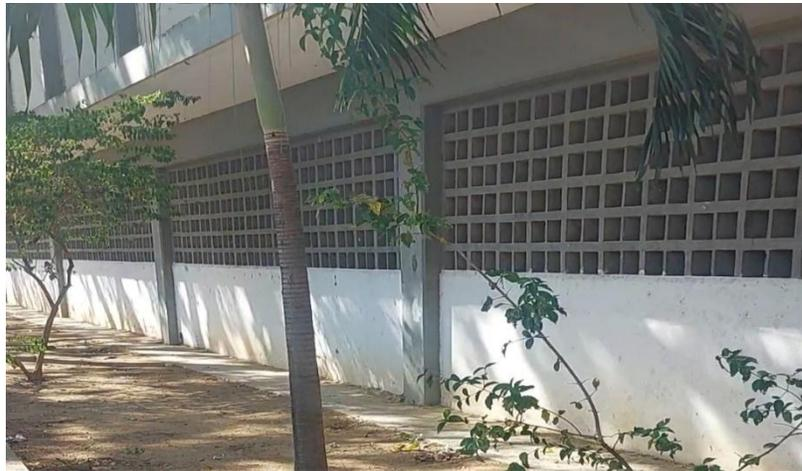
Figura 4.4. Presencia de columnas cortas. Ubicadas en las caras laterales de la edificación.
