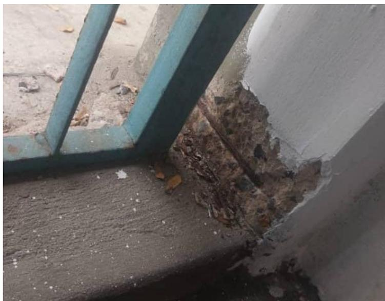
*Exposición y corrosión y de acero de refuerzo en columnas.*
