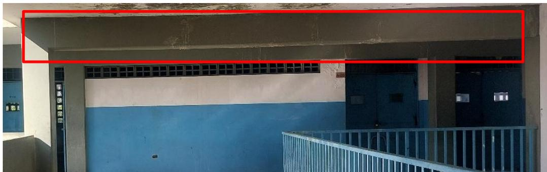
Figura 4.7. Humedad por filtración de la viga alta
