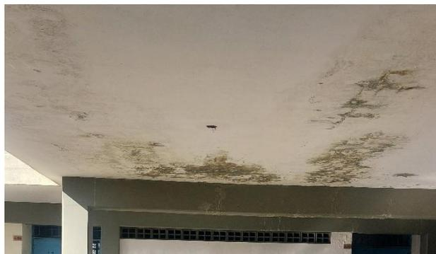
Figura 4.9. Humedad por filtración en la losa de techo
