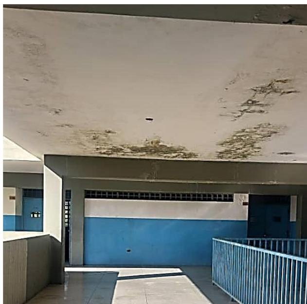
*Losa Techo con deterioro por humedad y desprendimiento de recubrimiento.*
