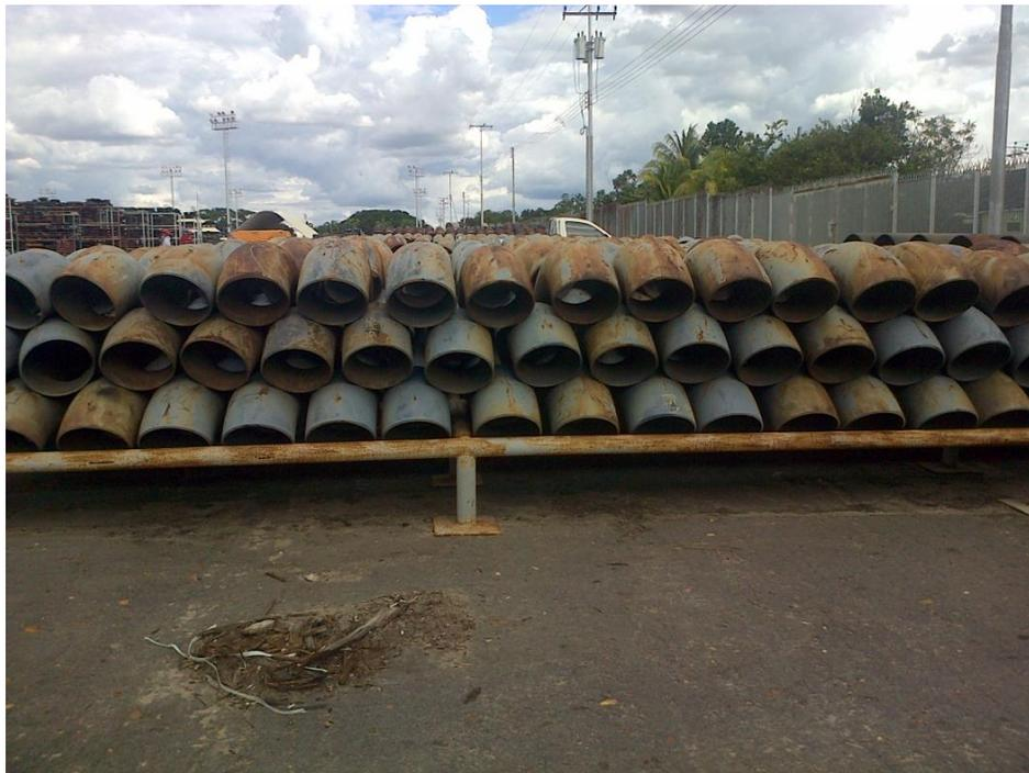
**Figura 4.4. Área externa, tubería de codos a la intemperie en mal estado**
