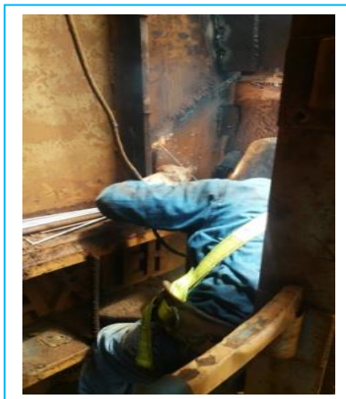
Figura 4.38 Colocación de planchas de acero para tapar grietas (Centeno, 2017)
