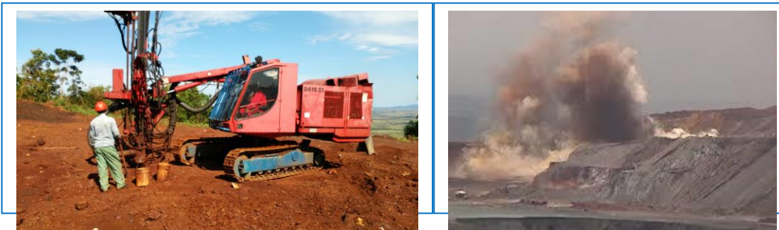
Figura 4.3 Perforación y Voladura de Hierro
