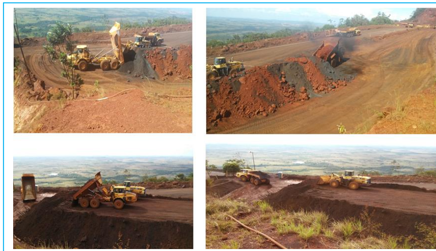
Figura 4.43 Apilado de material (Centeno, 2017).
