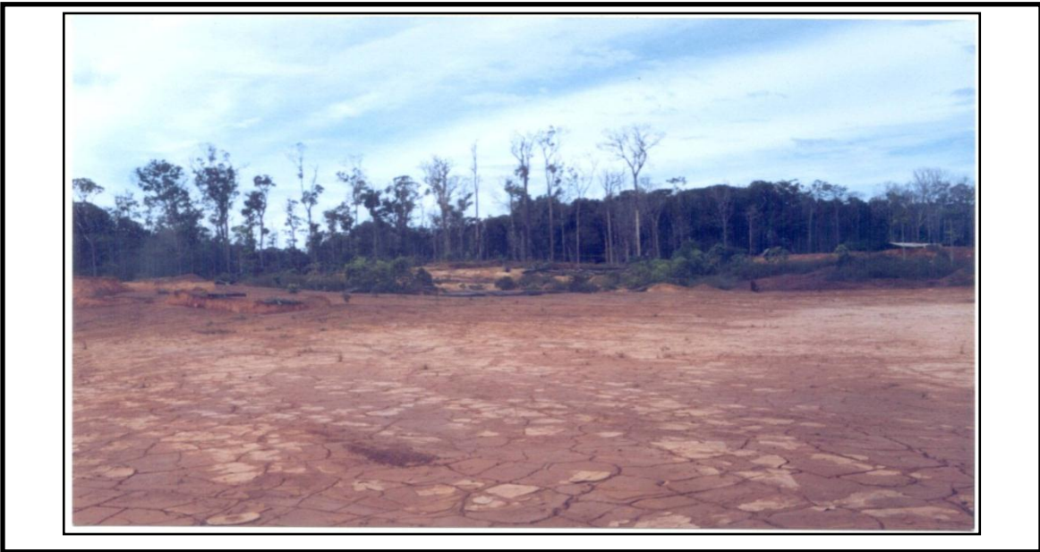
Figura A3. Suelos altamente erosionados (Sector Palo Floreo- Bizkaitarra )
