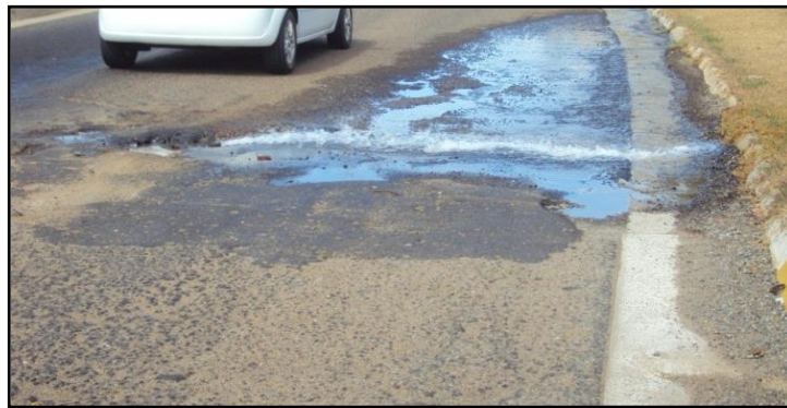
Figura 5.8 Avenida Andrés Bello
