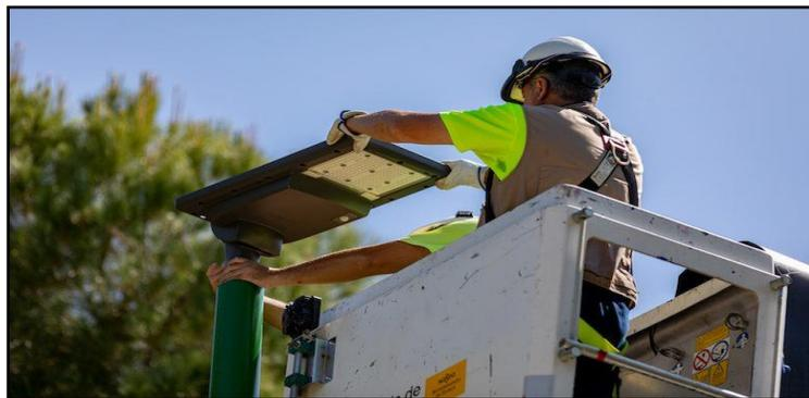
Figura 5.21 Técnicos cambiando una lámpara solar.
