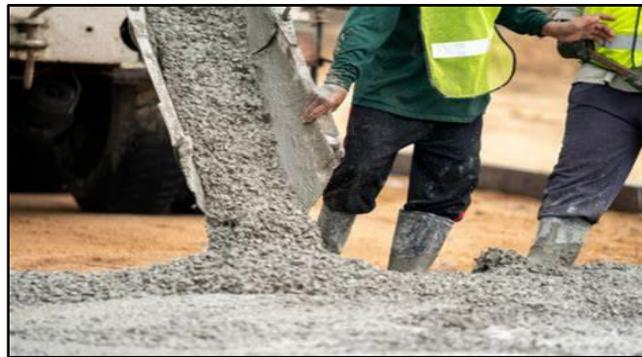
Figura 5.27 Concreto RCC 80 Kg/ cm 2 vertido.
