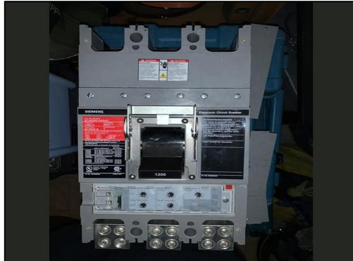
Figura 5.23 Breaker principal de 1200 A para tablero.
