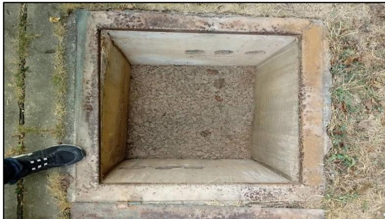
Figura 5.48 Tanquilla de concreto para electricidad.
