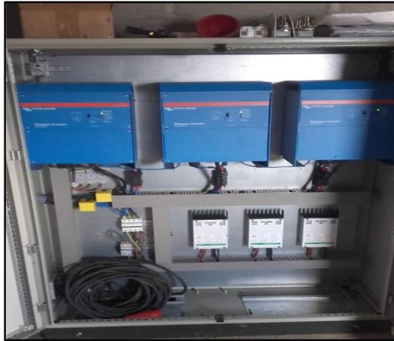
Figura 5.8 Tres inversores de 50 kW.
