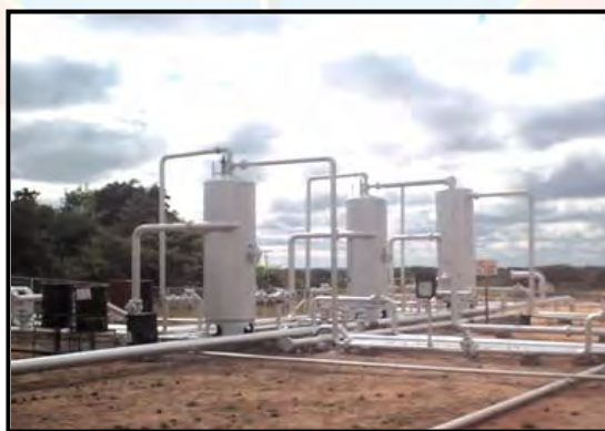
Figura N° 2.6. Separador Vertical para Gas-Petróleo.
