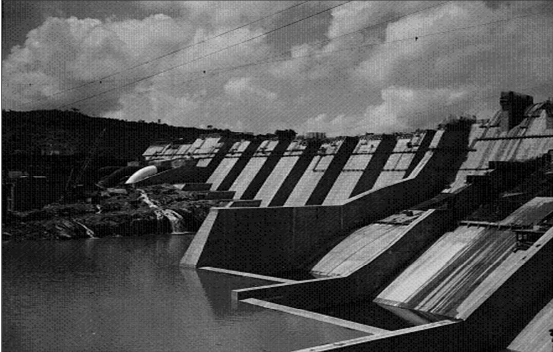
Figura 3.1. Deflectores de los canales del Aliviadero sumergidos en el agua.
