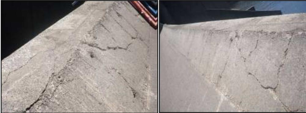
Fig. 5.6. Grietas en el borde derecho del lanzador. (Autor, 2009).
