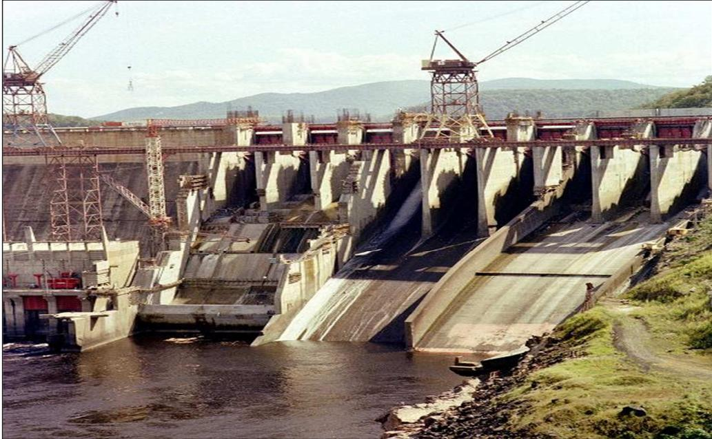
Figura 3.2. Realzamiento de los bordes del lanzador, trabajos de sobrelevación y rampas de aireación. Año 1981 (Intranet – EDELCA 2009).
