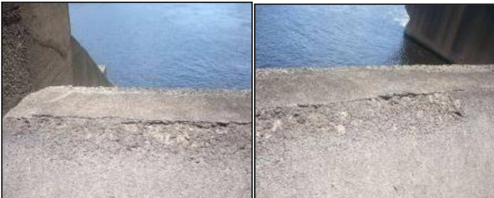
Figura 5.7. Borde izquierdo del lanzador con erosión. (Autor, 2009).
