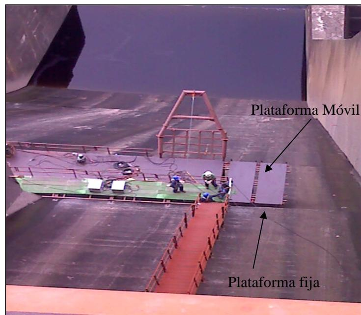
Figura 4.4. Plataformas fija y móvil instaladas en el canal 1. (Autor, 2009).
