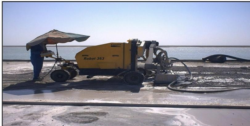
Figura 3.21. Hidrodemolición robotizada (www.hidrofrein.com, 2010).
