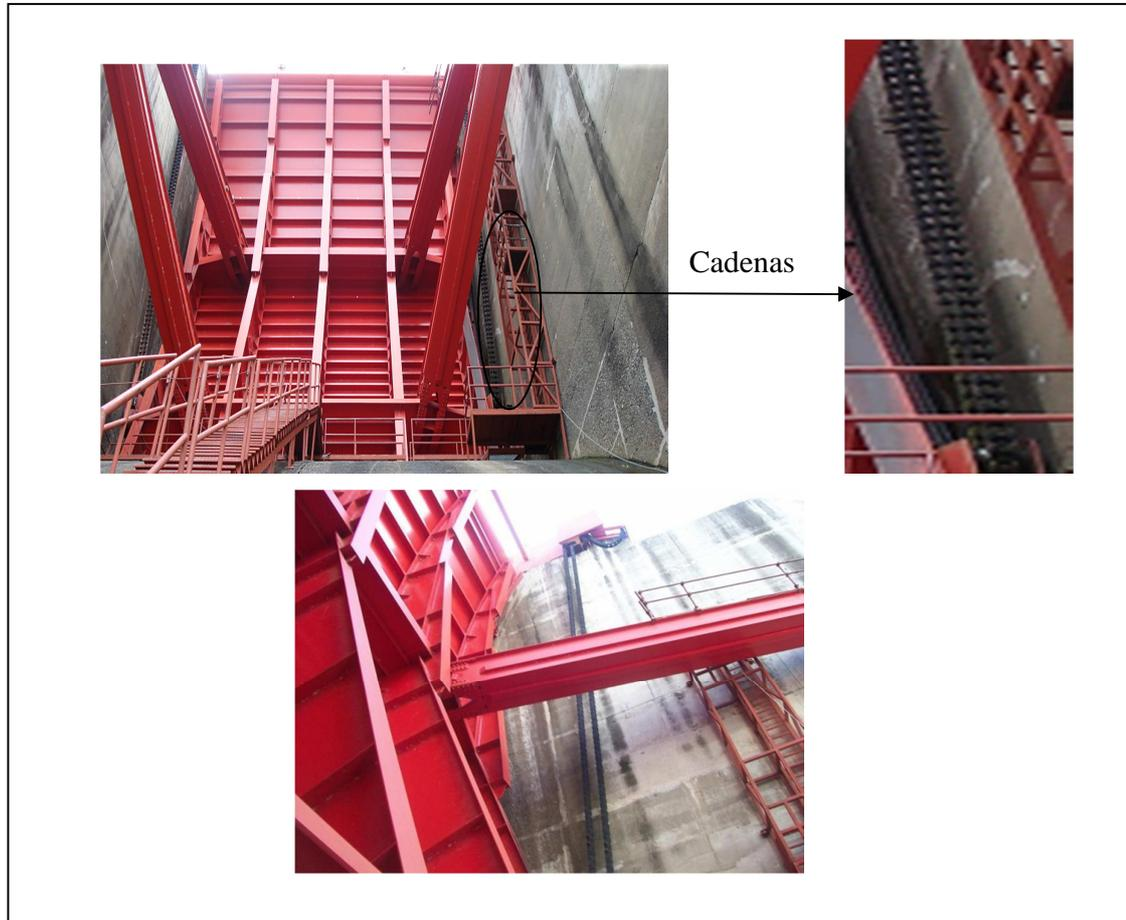
Figura. 5.3. Compuertas radiales del aliviadero de la central de Guri. (Autor, 2009).
