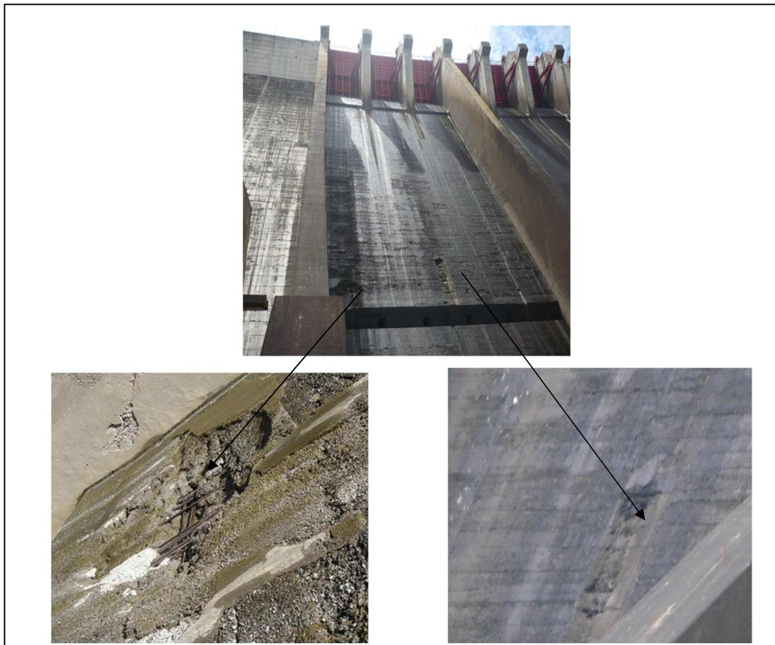
Figura 5.4 Daños en la segunda rampa de aireación del canal 1 del aliviadero de la presa de Guri. (Silva, 2009).
