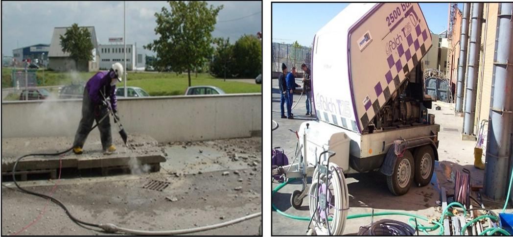
Figura 3.20. Hidrodemolición manual ([www.hidrofrein.com](http://www.hidrofrein.com), 2010).
