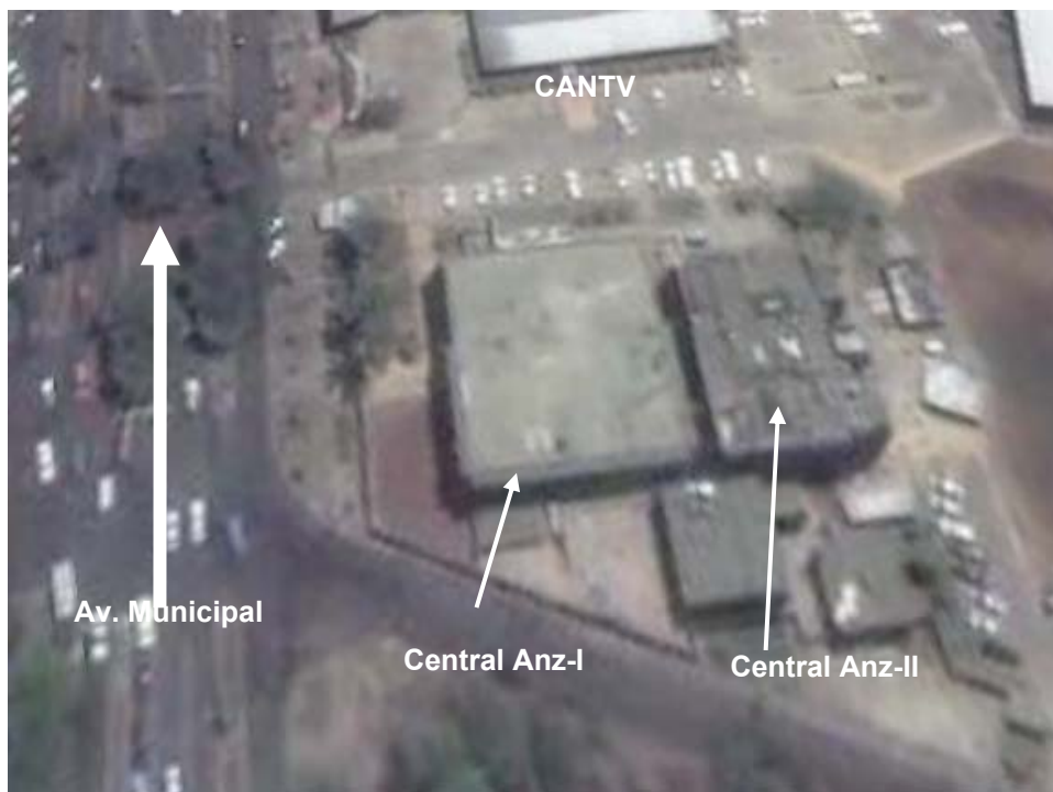
Figura. 3.1. Centro de Operaciones CANTV Puerto La Cruz. Satélite Google
