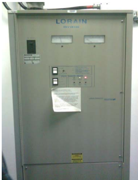
Figura. 4.14. PDB marca LORAIN Sala de Datos. Fuente CANTV.
