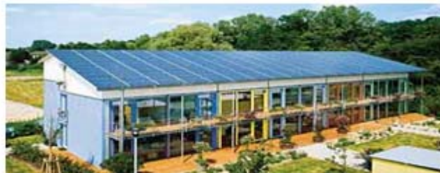
Figura 2.4. Casa con celdas solares. Ubicación de las celdas
