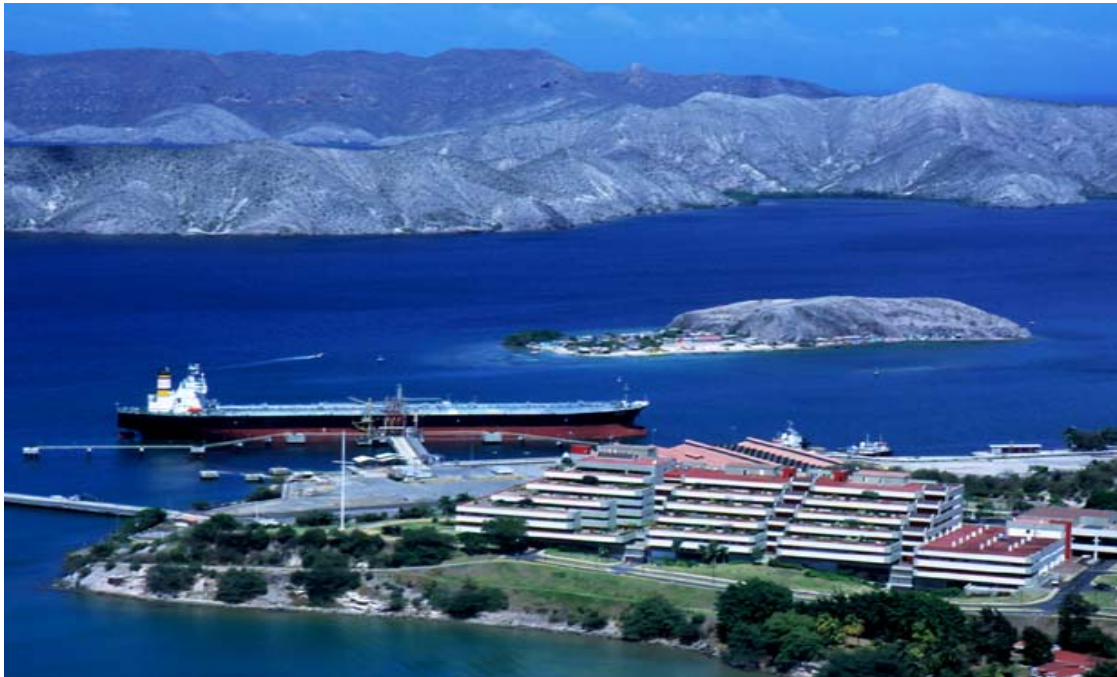
Figura.1.1. Ubicación del edificio Sede PDVSA de Puerto La Cruz
