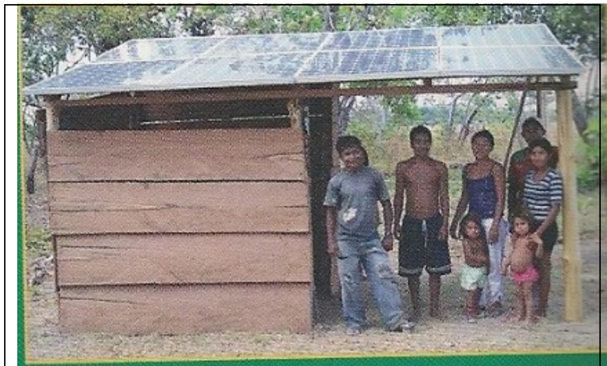
Figura 3.29 Estructura de Madera Instalada en Cojedes. [27]
