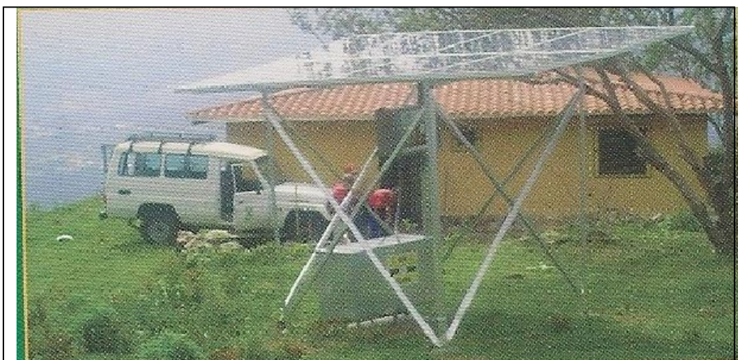
Figura 3.28 Estructura de Aluminio instalada en los Estados, Mérida, Trujillo, Portuguesa, Cojedes, Guárico, Miranda y Vargas. [27]
