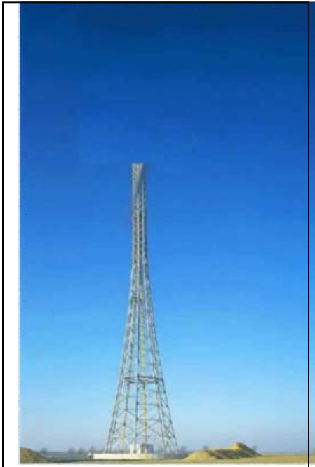
Figura 2.33 Torre de Celosía para Aerogenerador de Eje Horizontal. [17]
