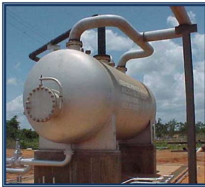
Figura 11: Separador Horizontal por Gravedad.
