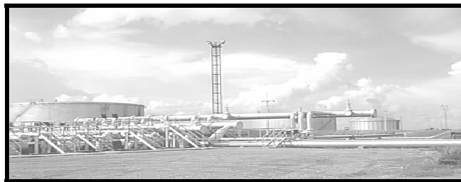
Figura 2.8 Estación de Descarga. [Fuente: Patio de Tanques Tejero]
