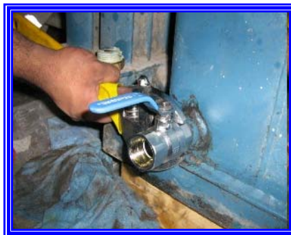
Figura N° 2.15. Válvula de Drenaje [8]
