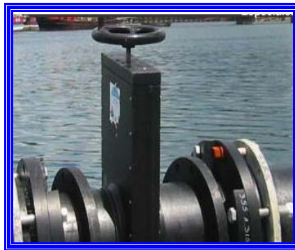
Figura N° 2.14. Válvula de Contra Presión [8]
