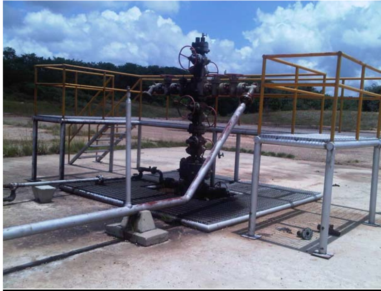
Figura N° 4.4. Fotografía de la locación del pozo ZM 347
