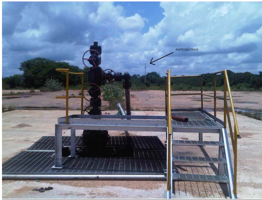
Figura N° 4.2. Fotografía de la locación del pozo ZM 349
