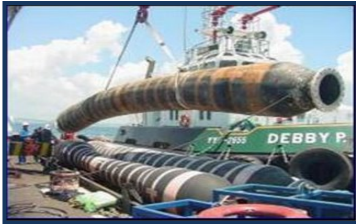
Figura 2.11 Manguera de suministro de crudo [8].
