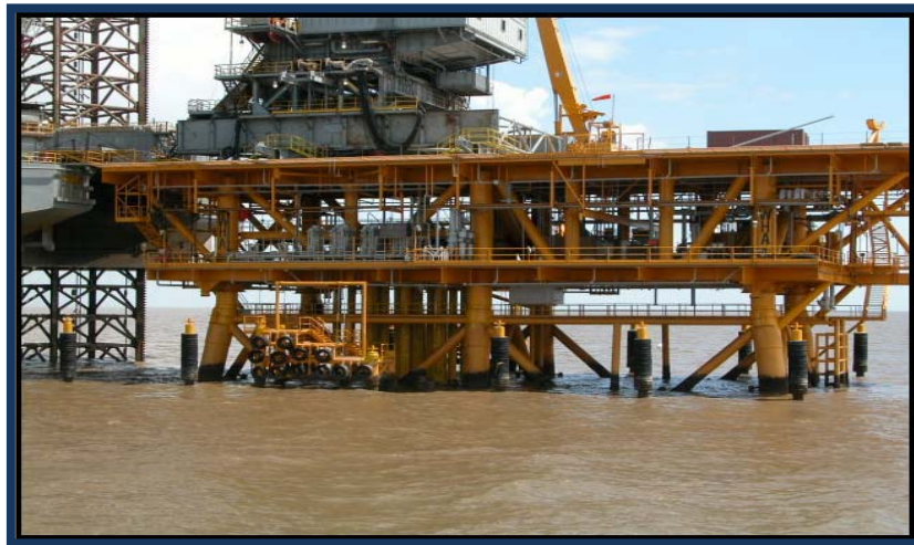
Figura 2.4 Vista lateral de la Plataforma de Pozos [6].
