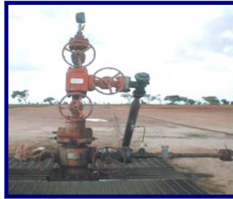
Figura 2.5. Cabezal de Pozo [11]
