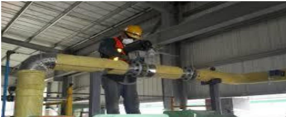
**Figura 4.4 Proceso de aislamiento térmico.**
