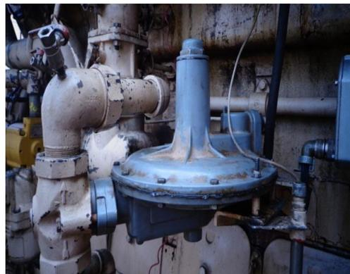
**Figura 4.3 Válvula de gas combustible**
