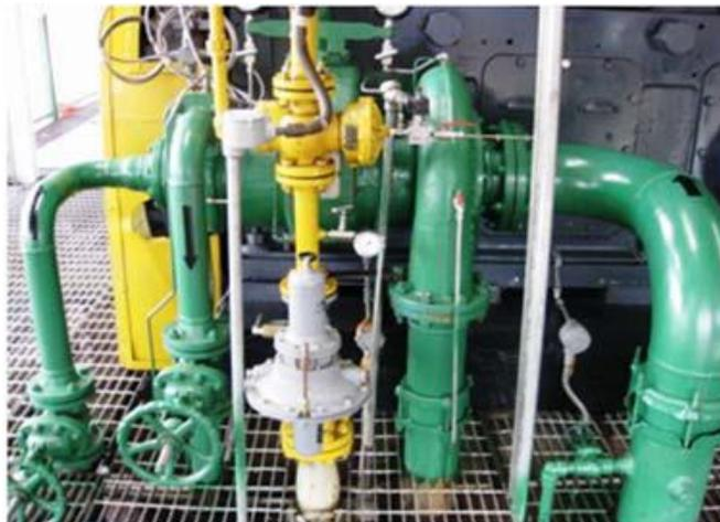
**Figura 2.5. Bomba centrífuga engranada al motocompresor**
