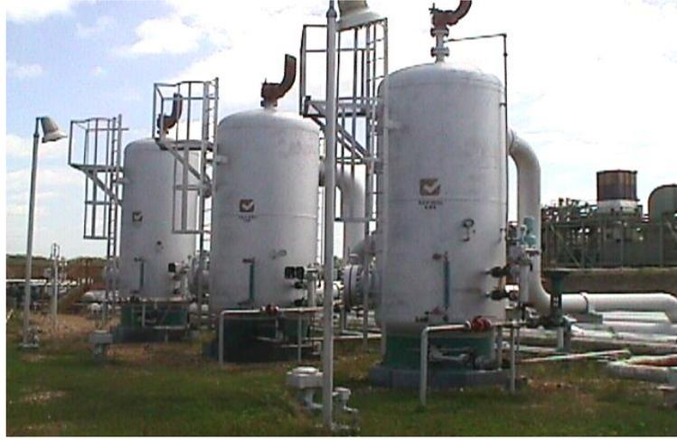
**Figura 4.4. Sistema de depuración de la PCSAIII**
