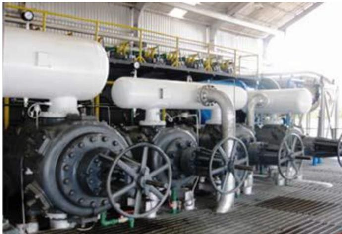
**Figura 2.4. Motocompresor integral reciprocante**
