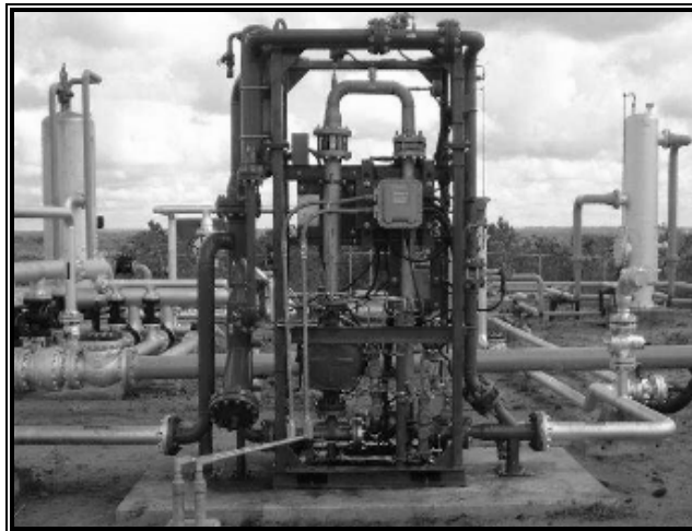
Figura 2.4. Medidor de Flujo Multifásico AGAR [9]
