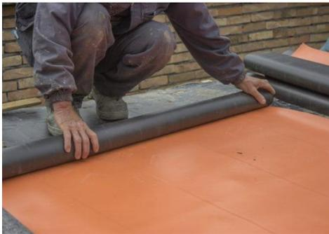
**Figura 9. Impermeabilizante flexibles, lamina PVC**
