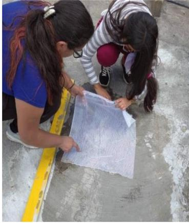
**Figura 16. Aplicación con malla de poliéster**
