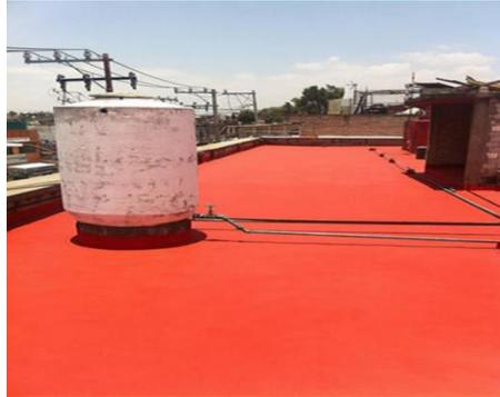
**Figura 7. Impermeabilizante flexibles, acrílico**
