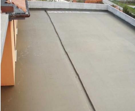
**Figura 6. Impermeabilizante rígido, cementoso**
