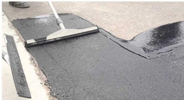
**Figura 11. Impermeabilizante flexible, asfáltico en frío**
