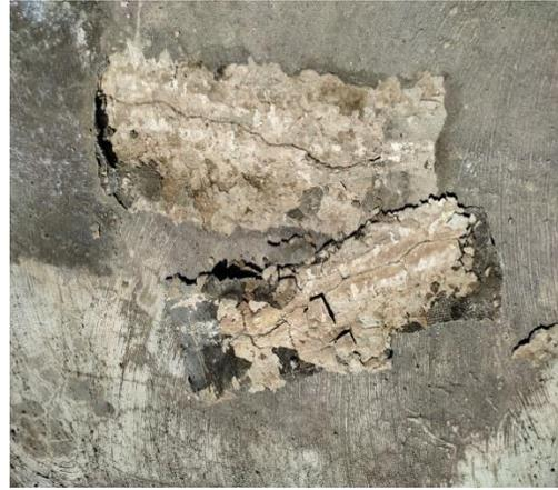
**Figura 25. Falla en la adherencia**
