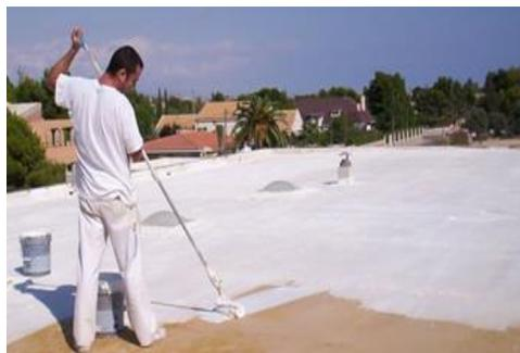
**Figura 8. Impermeabilizante flexible, elastomérico**
