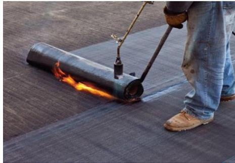
**Figura 10. Impermeabilizante flexible, asfáltico en caliente**
