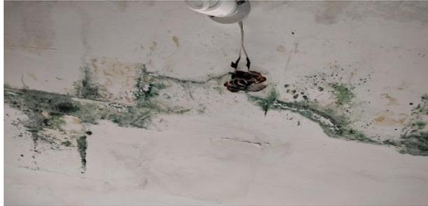
**Figura 4. Techo con efecto de humedad y filtración**
