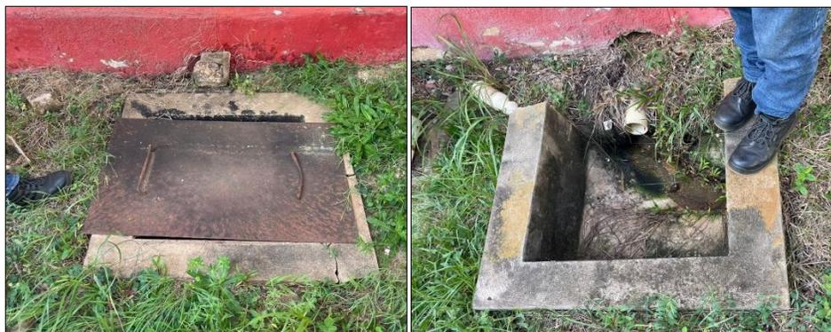
**Figura 21. Tanquilla de descarga.**
