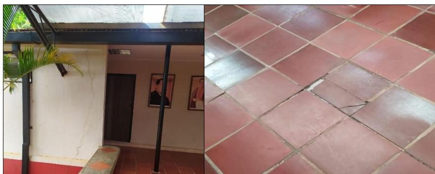
**Figura 16. Agrietamiento de piso y pared en el área externa.**
