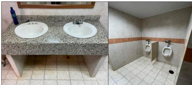
**Figura 19. Piezas sanitarias deterioradas.**
