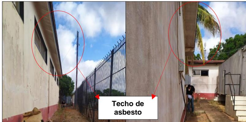
**Figura 12. Materiales riesgosos para la salud, techo de asbesto.**
