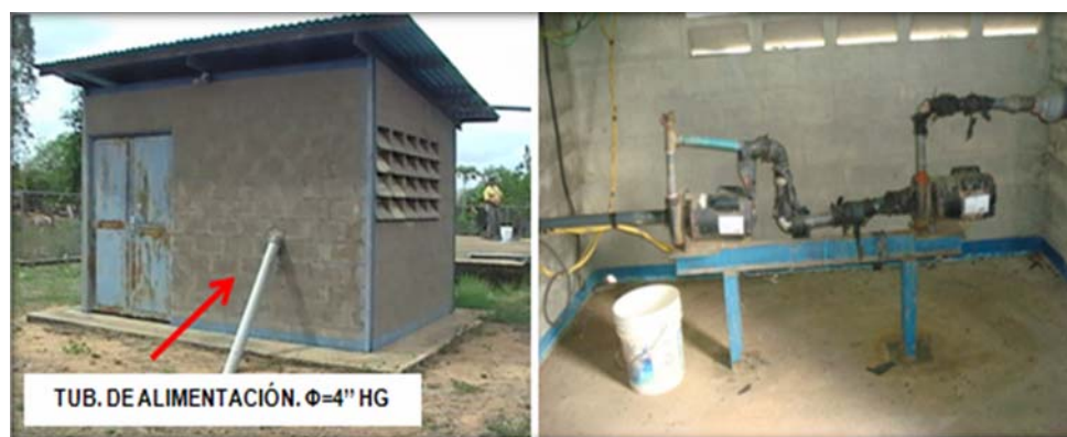
Figura 3.11. Estación de Bombeo Pozo Pilón N°1. (a) Caseta de Bombeo, (b) Bombas.
