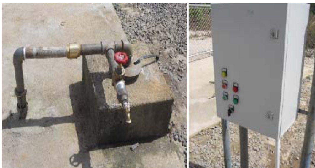
Figura 5.5. Obras de Rehabilitación Pozo Pilón N°2. (a) Pozo Pilón N°2 y (b) Nuevo Tablero Eléctrico.
