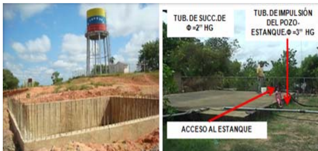
Figura 3.19. Estanques. (a) Estanque Elevado Bolivariano y Enterrado, (b) Estanque Semienterrado.
