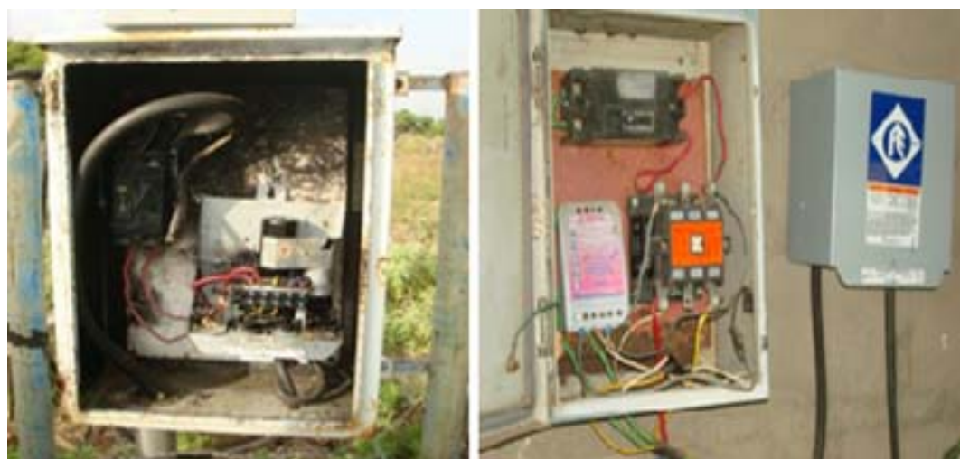
Figura 3.12. Tableros Eléctricos. (a) Pozos Pilón N°2, (b) Pozo Pilón N°1
