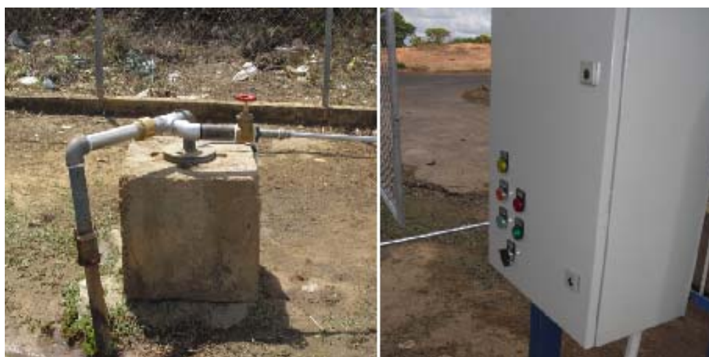
Figura 5.6. Obras de Rehabilitación Pozo Bolivariano. (a) Pozo Bolivariano y (b) Nuevo Tablero Eléctrico.
