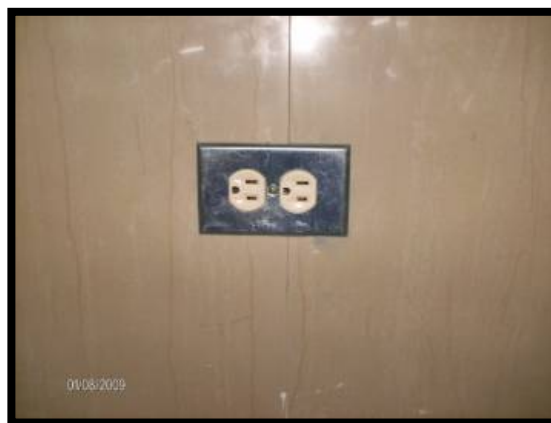
Figura 4.5 Toma en quirófano
