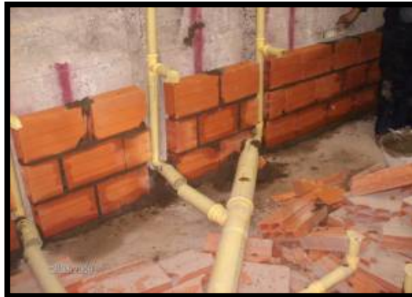
Figura 4.4 Instalaciones de descargas en baños
