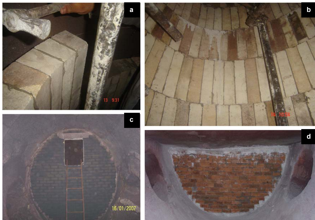
Figura 3.15. Ejemplo de actividades de reconstrucción de ladrillos densos: a) y b) construcción de pared cilíndrica de la cámara de combustión de HyL con ladrillos densos tipo arco, c) pared circular del ducto recuperados de pellas, d) pared media luna del ductor recuperador de pellas.
