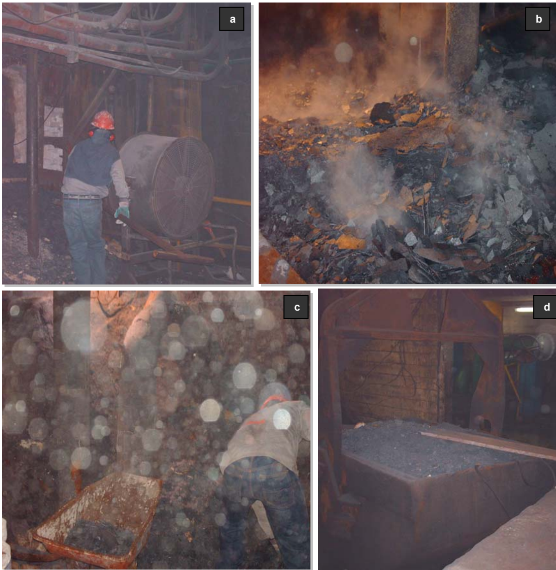
Figura 3.14. Ejemplos de fases de extracción de láminas y escoria de hornos: a) Puerta del horno con extractores de aire; b) escoria dentro del horno; c) colocación del material en carretillas; d) traslado en cajas metálicas.
