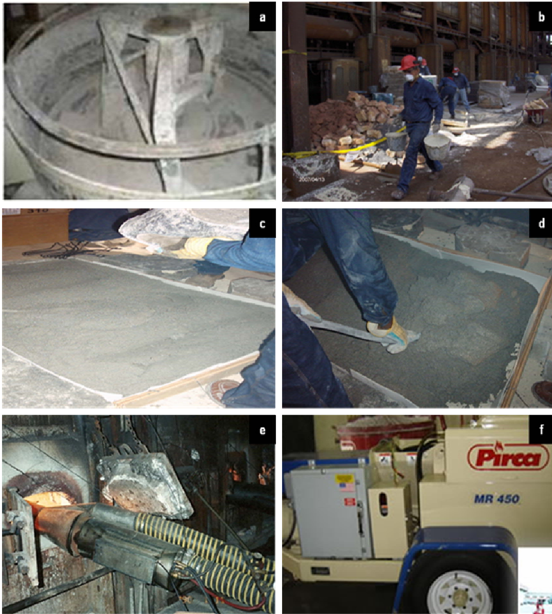
Figura 3.10. Ejemplos de las etapas y equipos utilizados en el revestimiento por vaciado: a) mezcladora intensiva, b) transporte de la mezcla mediante baldes; c) vertido en piso de la mezcla; d) vibrado; e) disposición del equipo de secado imagen referencial de la empresa Reframec; f) equipo de secado utilizado por Pirca (empresa que normalmente presta sus servicios de secado a SIDOR).
