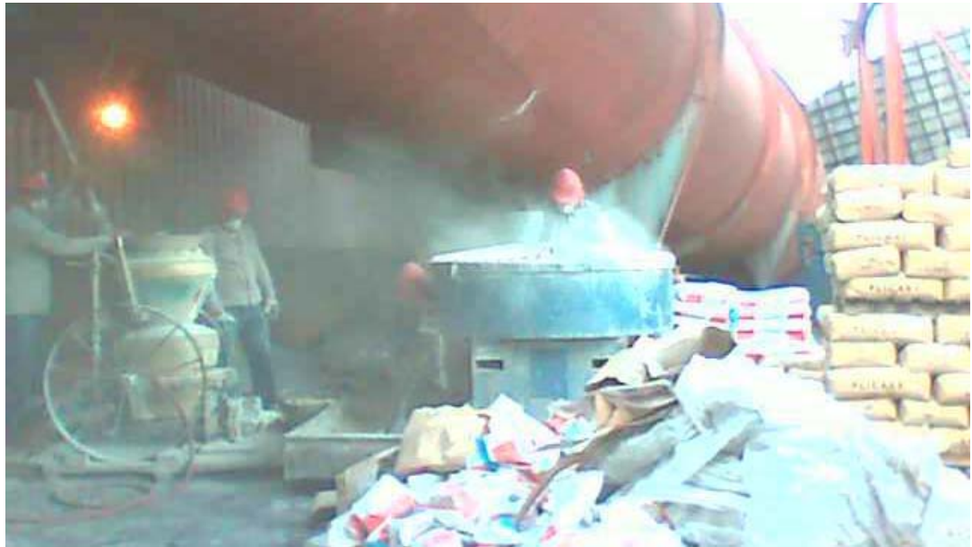
Figura 3.9. Imagen de la preparación de la mezcla para ser instalada por proyección
