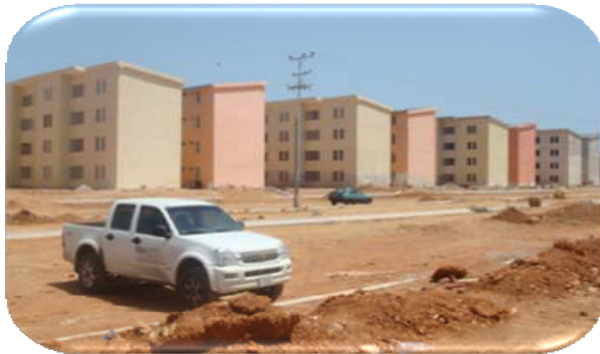
Figura 3.19 Urbanización en Construcción “Jesucristo es el Camino”
