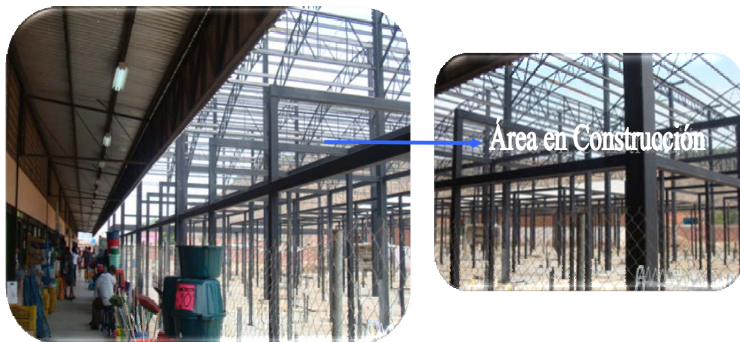
Figura 3.11 Área en Construcción para la Venta de Pescado y Pollos Vivos.
