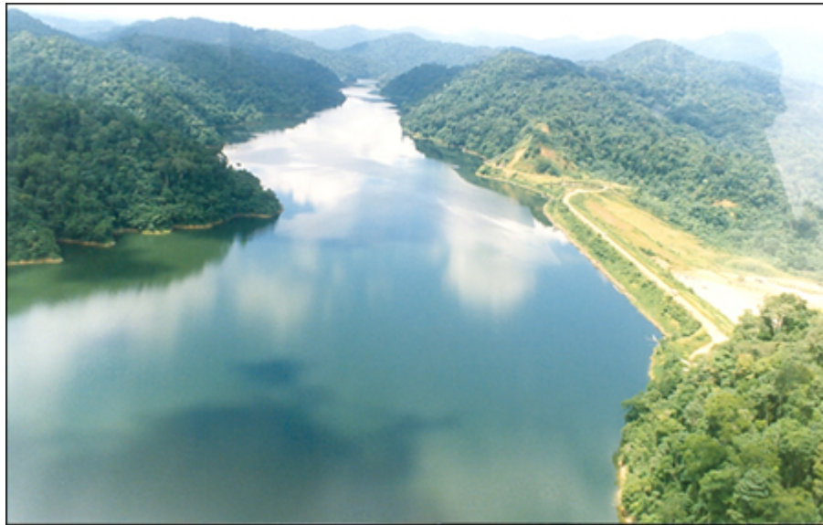
Figura N° 2.15. Presa El Guapo, antes de la falla.
