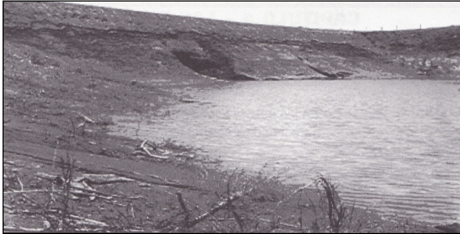
Figura N° 2.12. Presa Las Tinas, túnel en el terraplén
