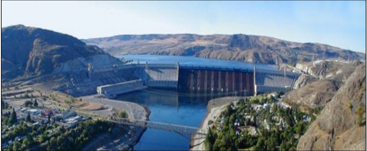
Figura N° 2.7 Vista panorámica de la presa Grand Coulee, mirando al sureste. La central eléctrica número tres, que se encuentra abajo a la izquierda de la presa, es lo bastante grande como para albergar cinco campos de fútbol.
