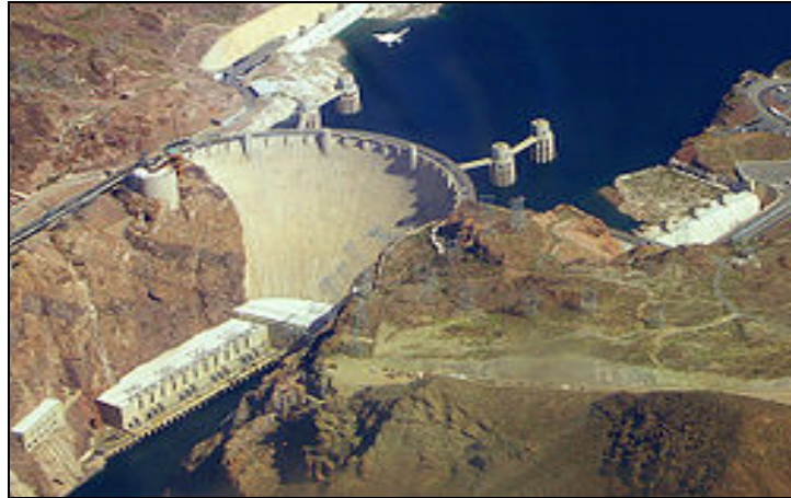
Figura Nº 2.6. La Presa Hoover desde el aire.
