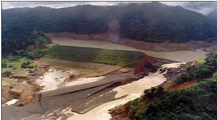
Figura N° 2.21. Presa El Guapo, después de la falla.
