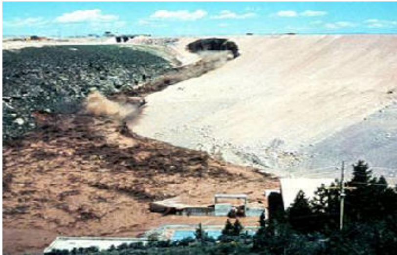
Figura Nº 2.8 Vista noroeste hacia el estribo derecho Represa el Tetón. El hueco en la cara de la presa crece hacia arriba
