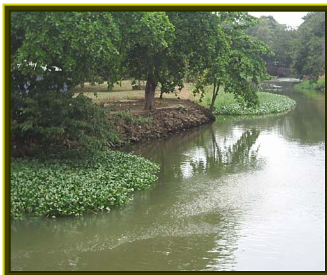
Fig. 23 Tramos sin Defensas en el Río Neverí
