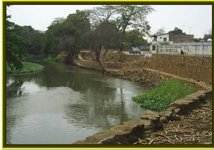
Fig. 20 Defensas en el Río Neverí
