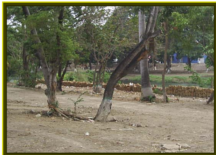
Fig. 21 Defensas del Río Neverí sin terminar
