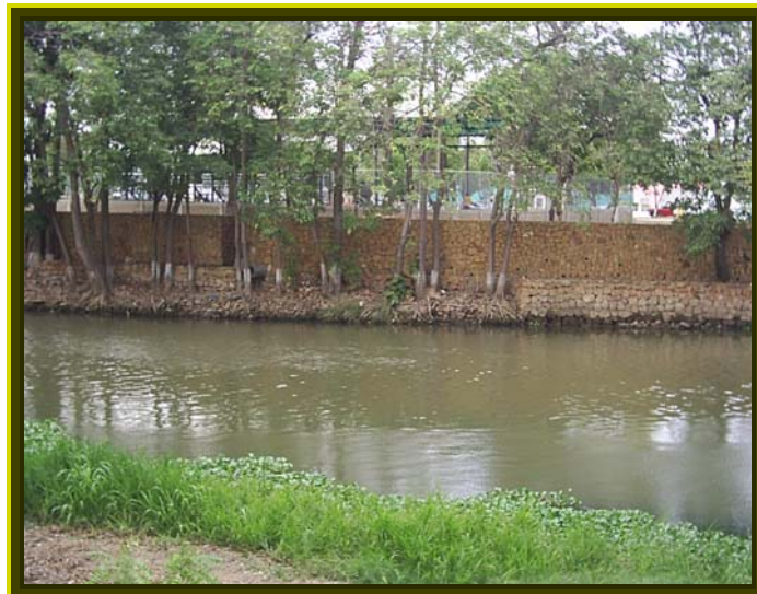
Fig. 22 Defensas en el Río Neverí
