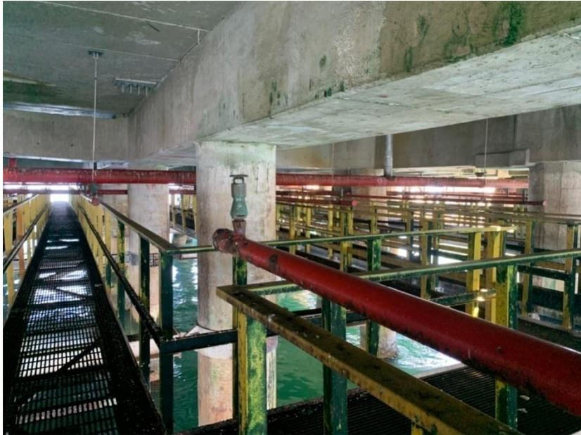
**Figura 4.16.** Vista del sistema de diluvio debajo de la plataforma de los muelles. **Fuente:** Propia. **(2024)**
