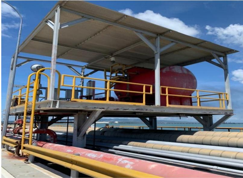
**Figura 4.7.** Plataforma donde se encuentra ubicado el tanque de espuma D8-90920 y la bomba del tanque D3-90920. **Fuente:** Propia. (2024)
