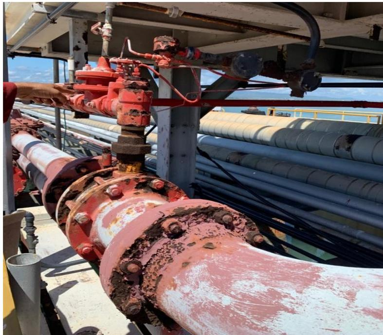
**Figura 4.8.** Equipo dosificador de espuma. **Fuente:** Propia. (2024)
