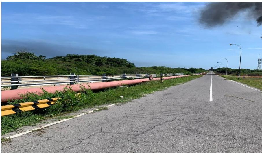
**Figura 4.4.** Tubería matriz de 24" (24"-AF-92601), encargada de transportar el agua de la estación de bombeo principal hasta la estación de bombeo del Terminal Marino. **Fuente:** Propia. **(2024)**
