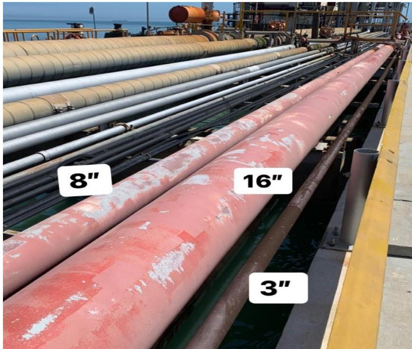
**Figura 4.9.** Tuberías que salen desde el equipo dosificador de espuma hasta la plataforma de carga. **Fuente:** Propia. **(2024)**
