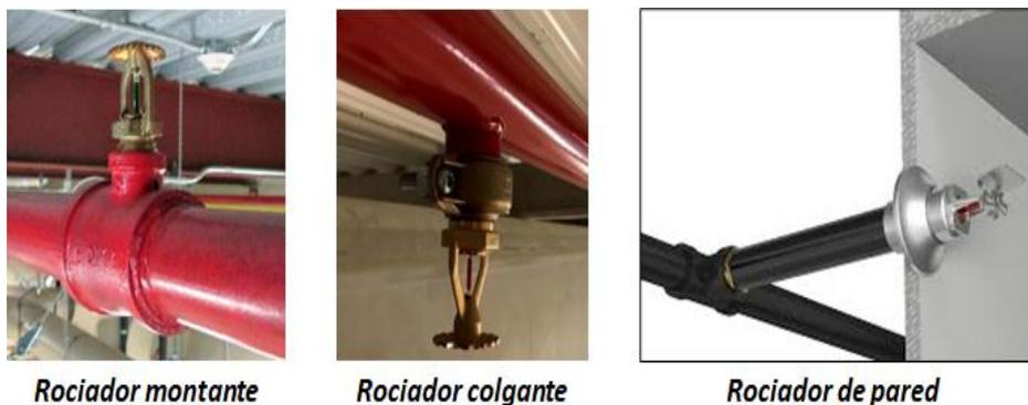
**Figura 2.3.** Tipos de rociadores según la orientación de su instalación.
