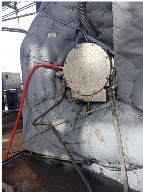
**Figura 4.21. Altas temperaturas en la caja de rodamientos.**
