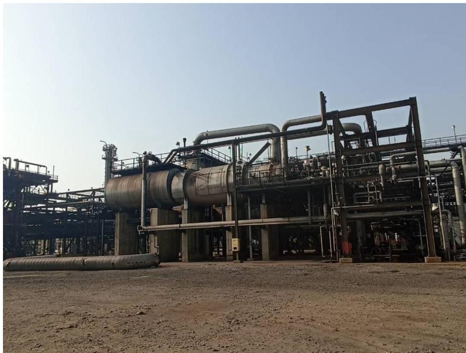
**Figura 4.5. Conjunto Quemador Principal, Cámara de Combustión y Caldera de Calentamiento Residual.**
