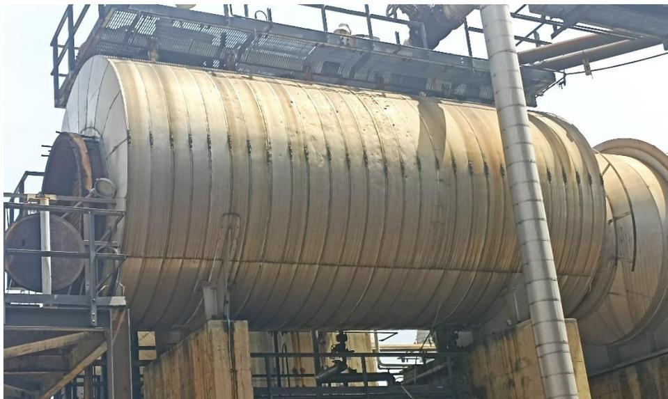
**Figura 4.6. Caldera de Calentamiento Residual. Fuente: Propia.**
