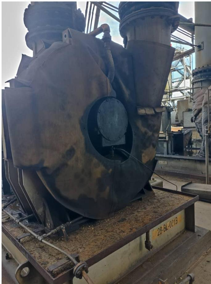
**Figura 4.30. Instalación inadecuada de la chaqueta térmica.**
