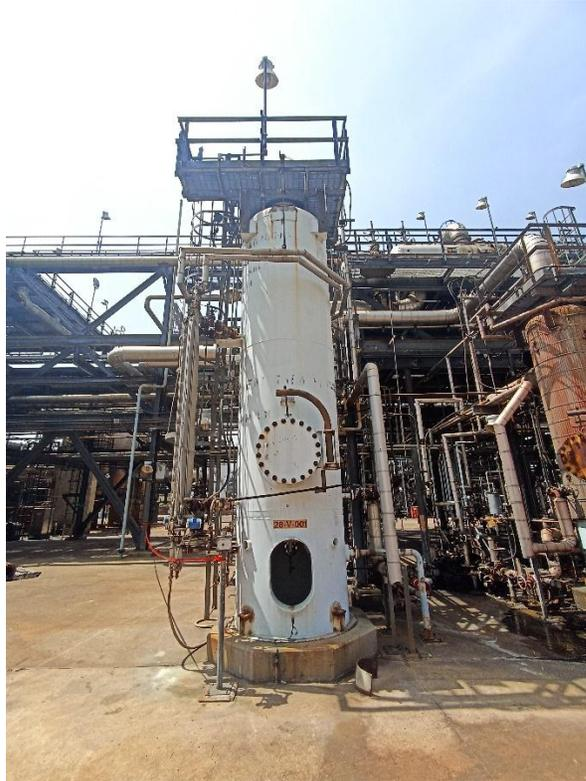
**Figura 4.2. Tambor separador de Gas Acido de Amina (28-V-001).**
