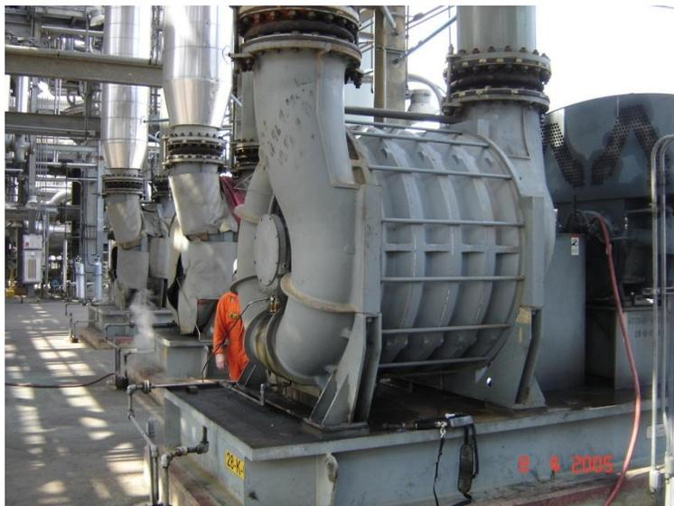
**Figura 4.4. Compresores de aire principal (28-K-01A/B/C).**
