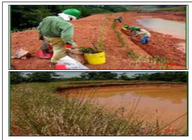
Figura 5.18 Siembra de Vetiver en lagunas de sedimentación.
