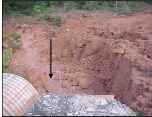
Figura 5.16 Socavación de fondo. Caño El Chorro.
