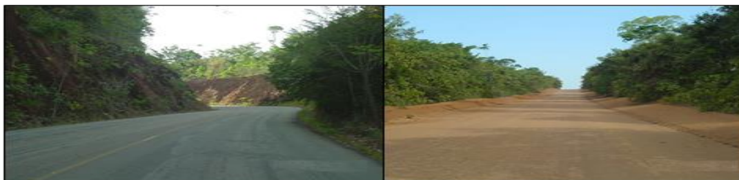
Figura 2.3 Vía de acceso al yacimiento asfaltada y engrazonada.
