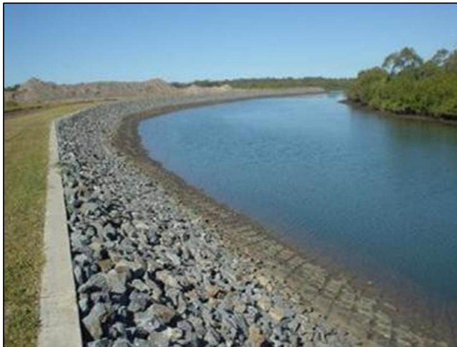
Figura 3.16 Recubrimiento marginal. (Maza, 1997).
