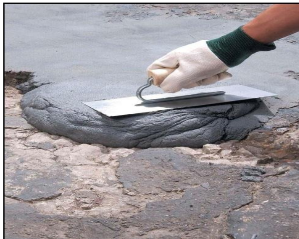
Figura 3.12 Aplicación de mortero hidráulico. (Azkárate, I., et al., 2005).
