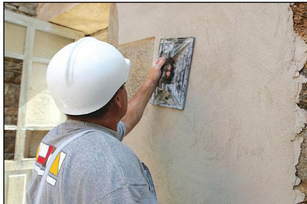
Figura 3.15 Aplicación de mortero para el revestimiento de paredes.
