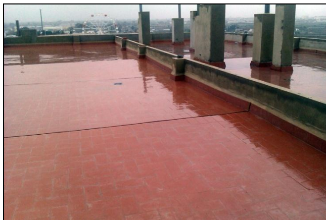
Figura 3.14 Impermeabilización de cubierta. (Azkárate, I., et al., 2005).
