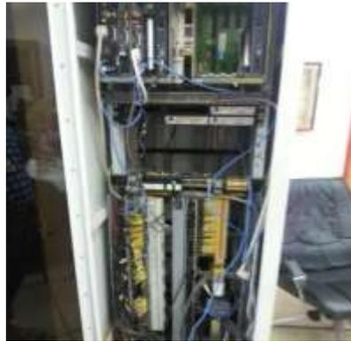
**Figura 9: Gabinete y PLC-5 ubicados en sala de control**
