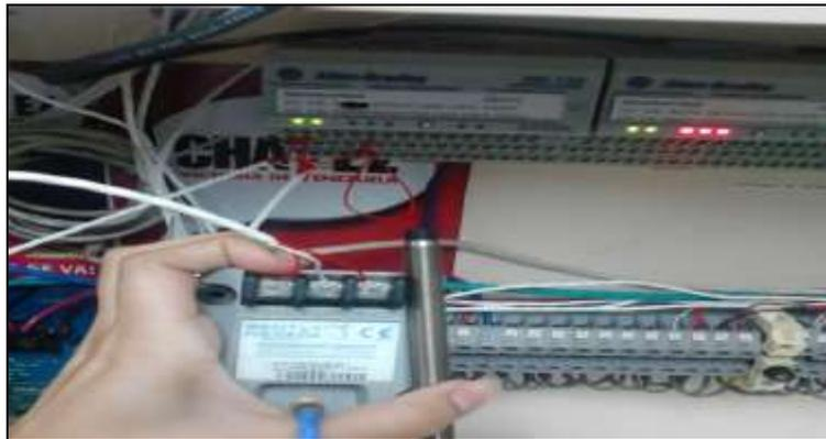
**Figura 20: Sensor conectado al transductor y al modulo XM**
