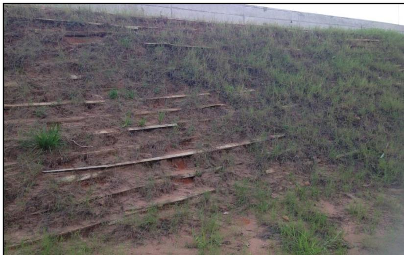
Figura 5.4 Mal recubrimiento de capa vegetal en el lugar de estudio.
