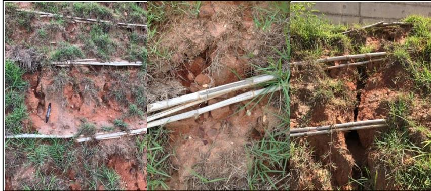
Figura 5.1 Estado actual de las cárcavas del talud de estudio
