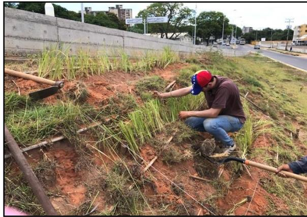
Figura 5.14 Colocación de los vetiveres en las 5 zanjas previamente hechas.
