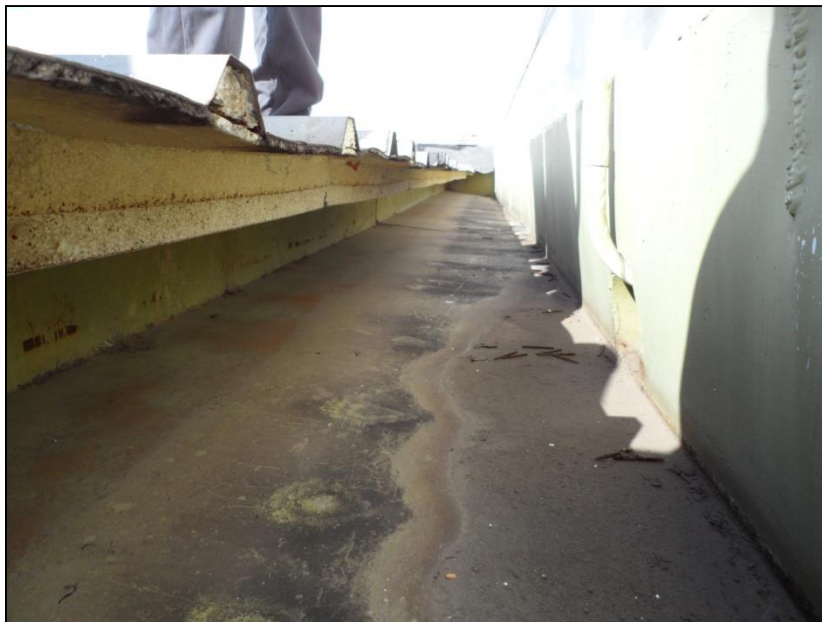
Figura 5.1 Canal de recolección de agua de lluvia del galpón.
