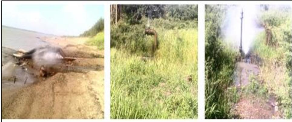
Figura 5.17 Fugas en la tubería de impulsión.
