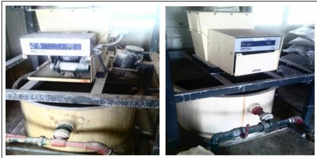
Figura 5.21 Dosificador de sulfato y dosificador de cal.
