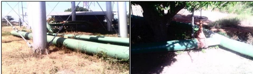
Figura 5.15 Tuberías de impulsión de la planta de tratamiento a las redes de distribución
