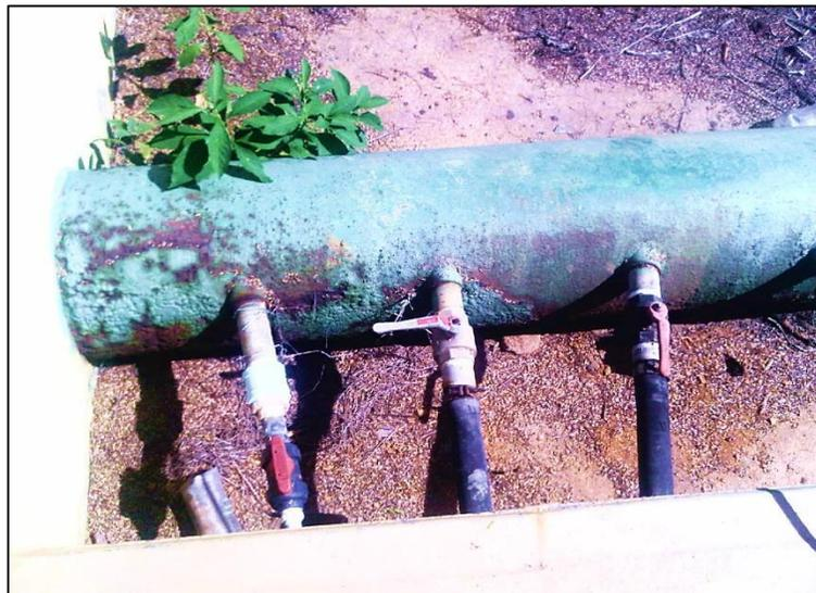
Figura 5.23 Colocación del cloro, cal y sulfato.
