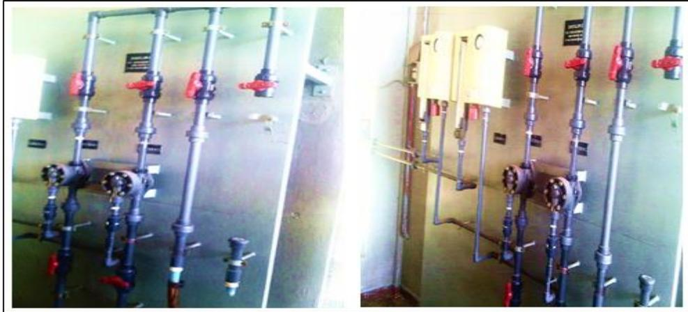
Figura 5.22 Dosificadores de cloro o Clorificadores.
