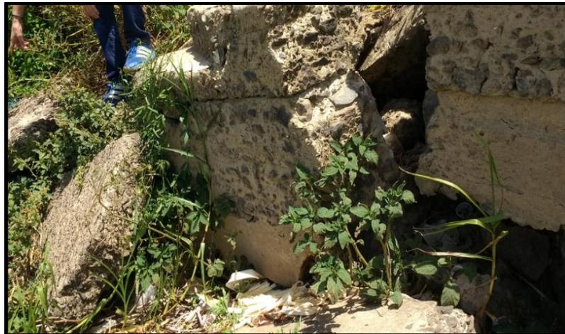
Figura 5.7 Extremo oeste del Malecón, colapsado por gravedad, obsérvese socavación inferior.
