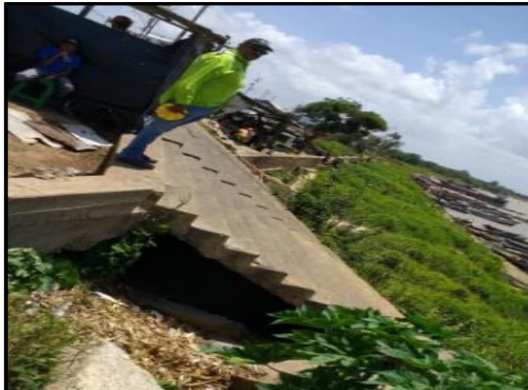
Figura 5.3 Socavación en los accesorios de servicio del malecón.
