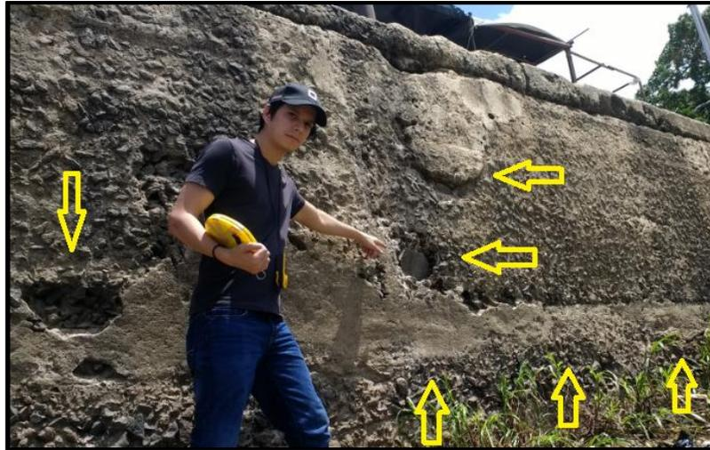
Figura 5.10 Reparaciones fallidas de las oquedades y fisuras en la superficie del muro.
