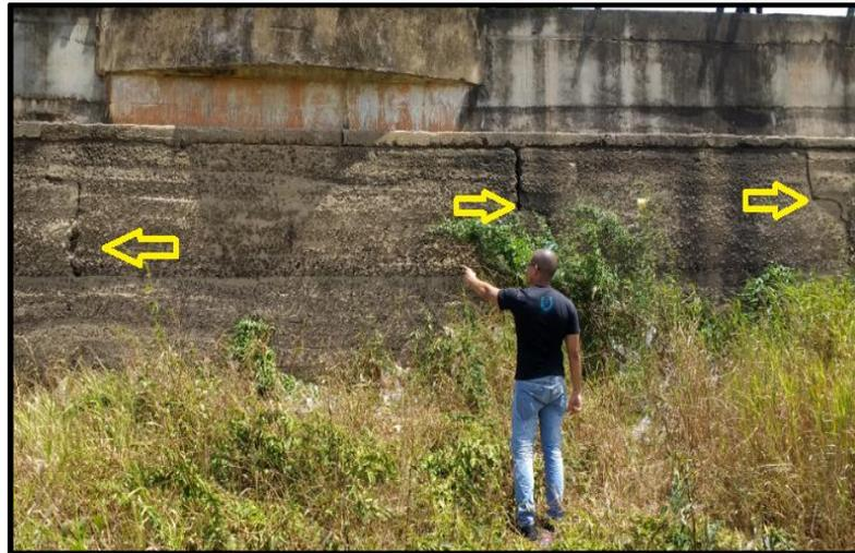
Figura 5.8 Fisuras tipo diaclasas que muestra la superficie del malecón.
