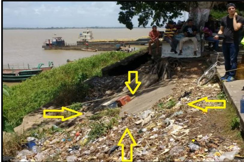
Figura 5.6 Carpeta superior del malecón totalmente erosionada.
