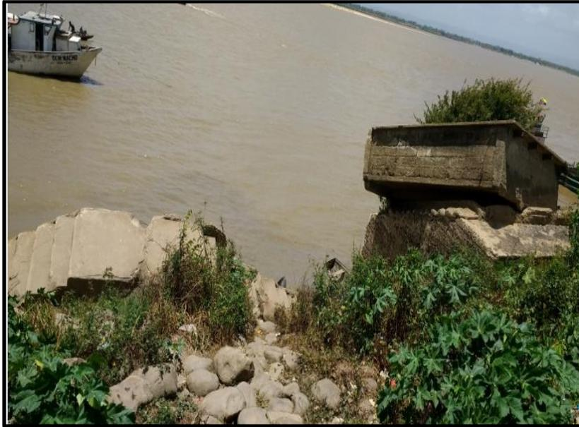
Figura 5.5 Tanque de servicio del malecón en equilibrio inestable por colapso de sus bases y rampa de acceso a escaleras de servicio totalmente erosionadas por la corriente.
