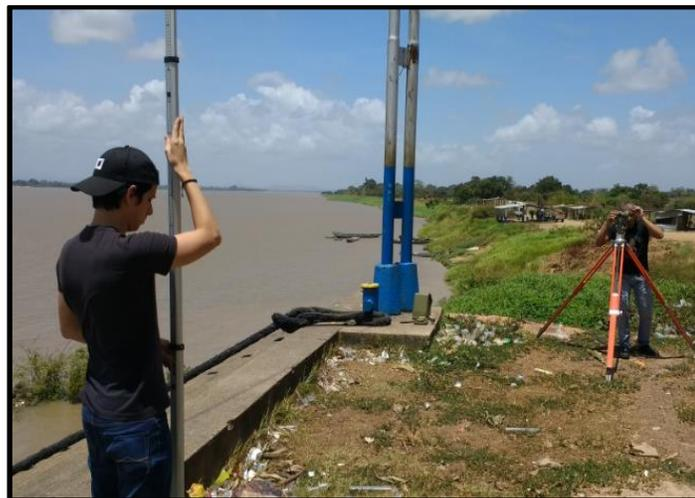
Figura 5.22 Levantamiento plani-altimétrico para determinar geometría actual del malecón.
