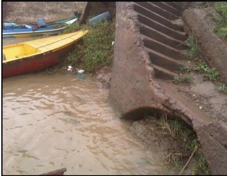
Figura 5.4 Escaleras de servicio colapsadas por socavación de sus bases.
