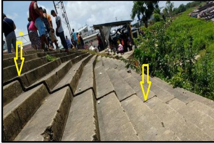
Figura 5.2 Nótese los asentamientos diferenciales donde indica la flecha.
