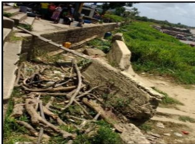
Figura 5.1 Muro erosionado y colapsado en el extremo Este del malecón.
