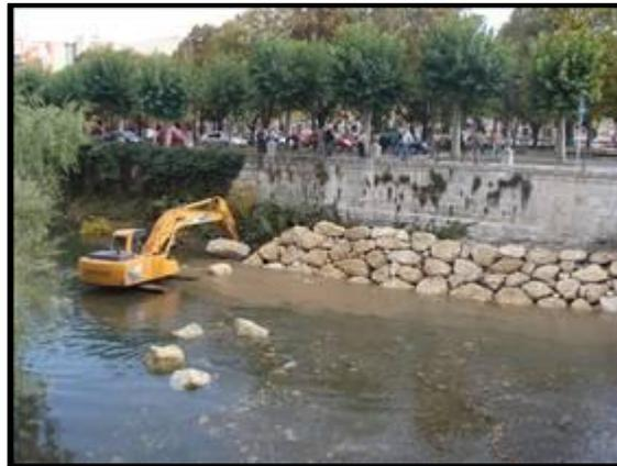
Figura 3.8 Protección de orilla con enrocado Riprap (Cardenas, 2012).
